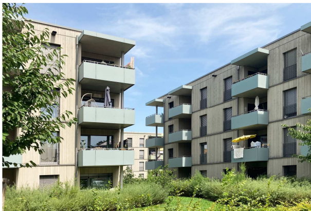
Zurückhaltende Balkone in Richtung Straßenraum
