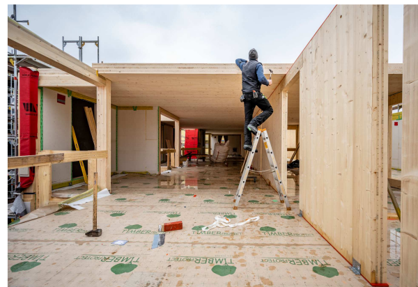
Serieller Holzbau in der Aufrichtungsphase Freiburg-Schildacker
