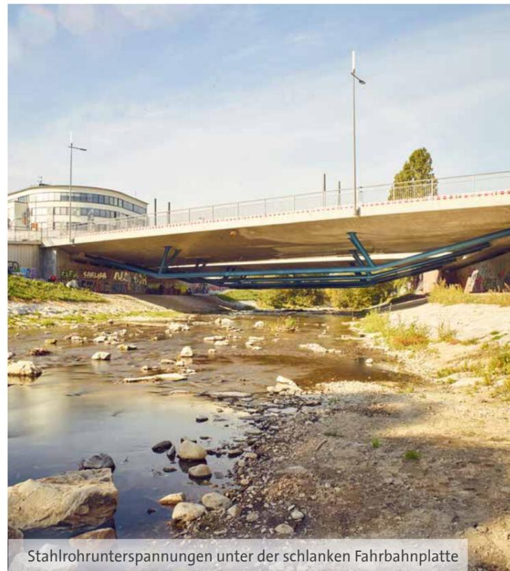
Stahlrohrunterspannungen unter der schlanken Fahrbahnplatte
