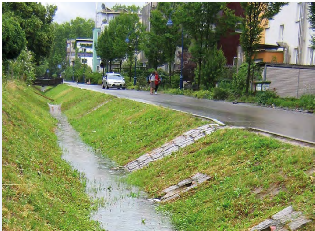
Semizentrale Mulden-Rigole zur Versickerung des Niederschlagswassers von Privatgrundstücken und öffentlichen Straßen, Freiburg, Vauban [Bild: Nicole Jackisch]
