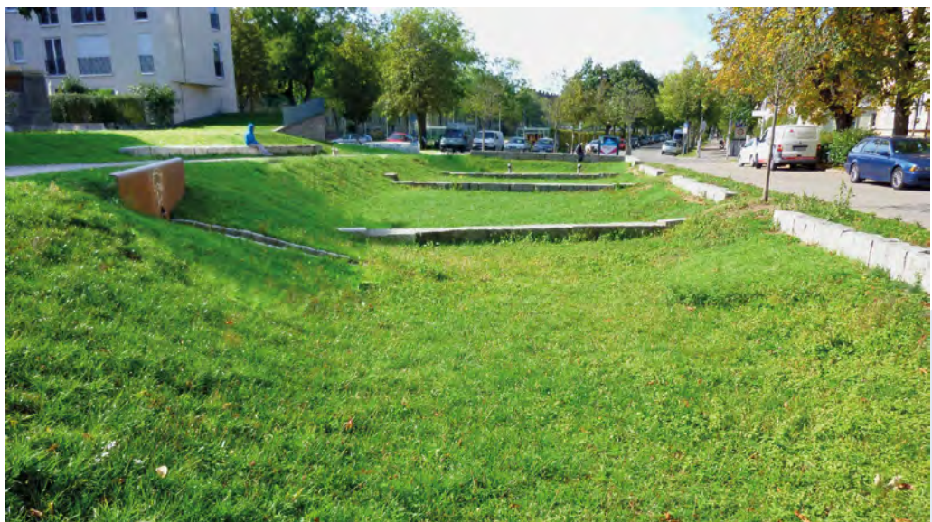
Mulden-Rigolen-Versickerung mit Überläufen am Beispiel einer semizentralen Anlage, Freiburg, Wiehre [Bild: UWSA FR]
