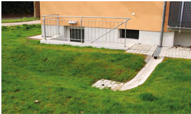
Beispiel einer kleinen Mulde zur Versickerung von Dachwasser eines Wohnhauses, Freiburg, Betzenhausen [Bild: UwSA FR]
