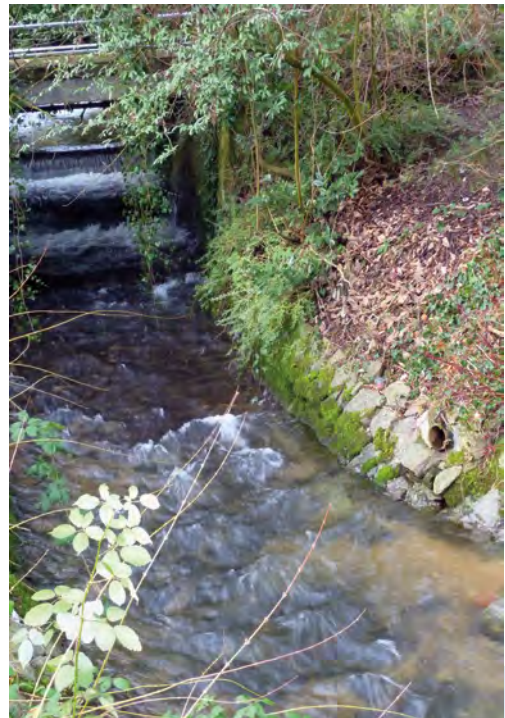
Einleitung in den Hölderlebach, Freiburg [Bild: UwSA FR]
