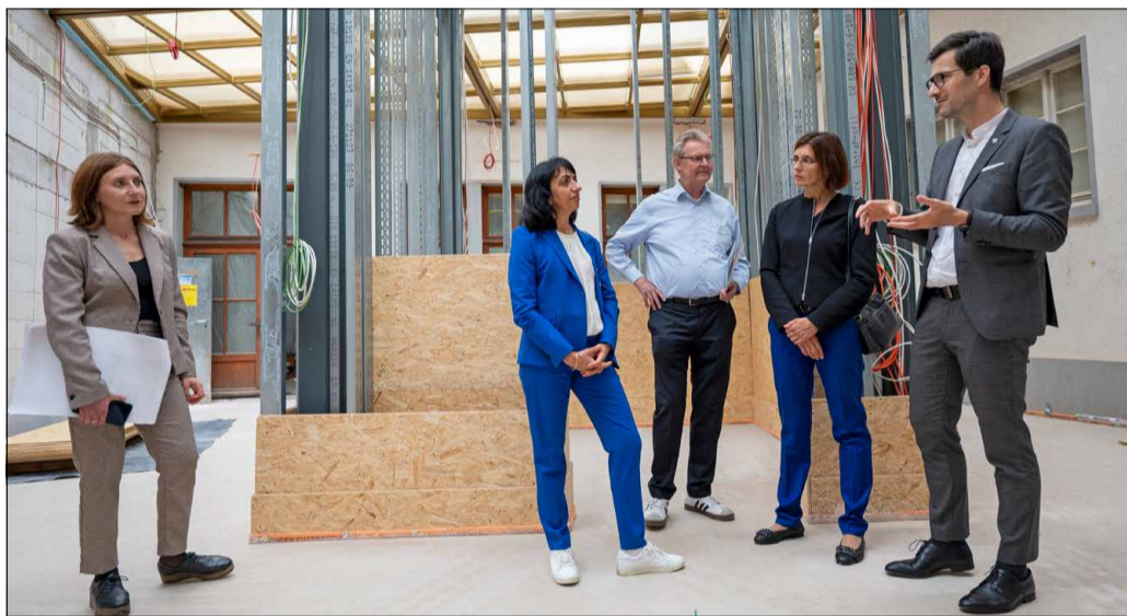
Freuen sich über die Unterstützung: Julia Wolrab, Leiterin des NS-Dokuzentrums, Erster Bürgermeister Ulrich von Kirchbach, Bürgermeisterin Christine Buchheit und OB Martin Horn (v. l.) beim Baustellen-Rundgang mit der künftigen Schirmherrin Muhterem Aras (Zweite v. l.).
