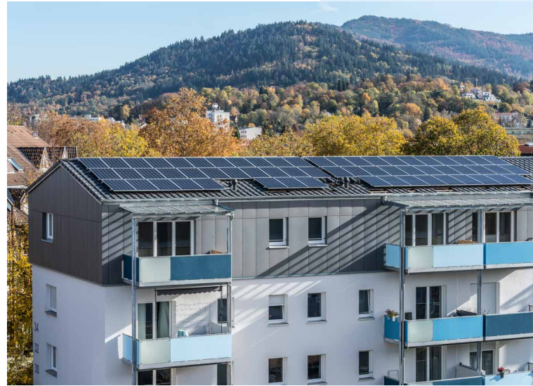
Umsetzung eines Mieterstrommodells mit Photovoltaikanlagen in der Belchenstraße
