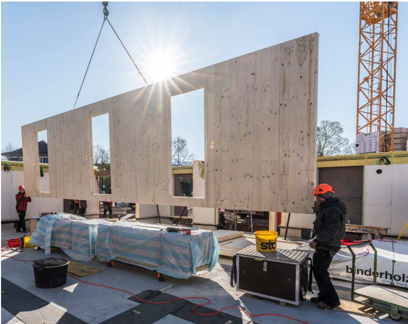
Baustelle der Wohngebäude in Holzbauweise im Schildacker
