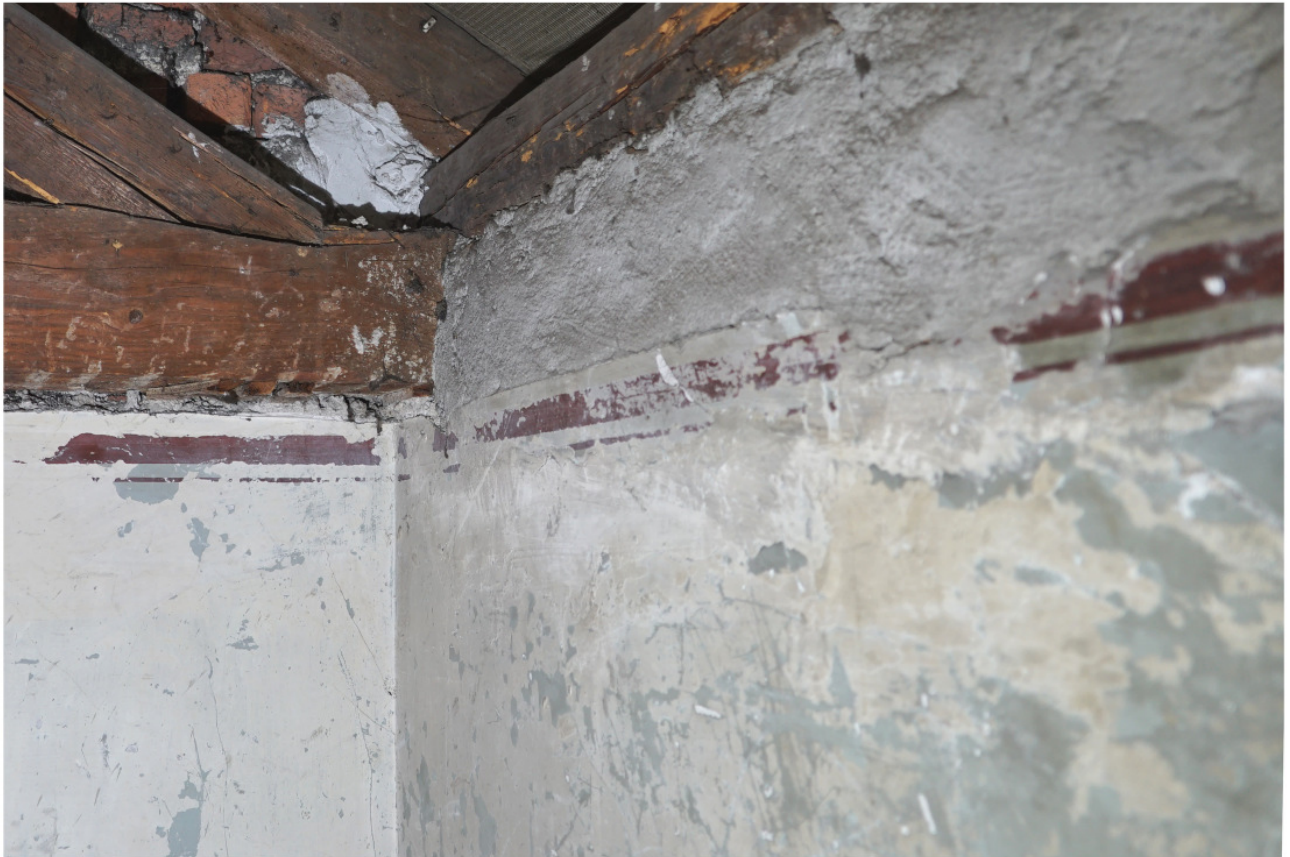
Rechter Eingang, Treppe ins Dach: Reste eines früheren gemalten Bands unterhalb der Decke, wo später das Treppenloch durchgebrochen wurde 13
