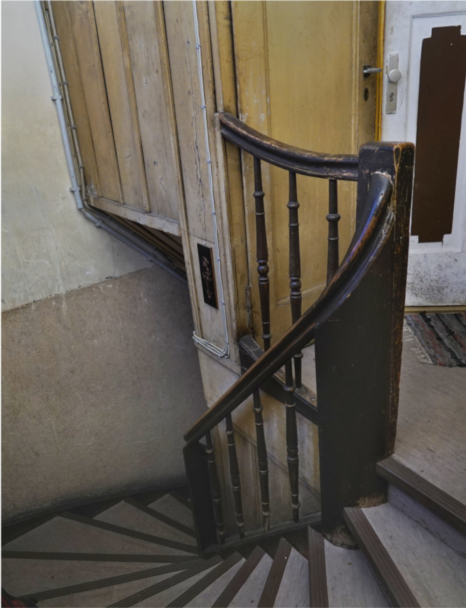
Mittlerer Eingang: Treppe ins Obergeschoss
