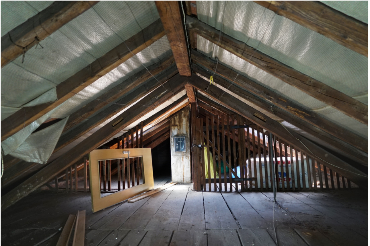
Linker Eingang, Dachwerk, Blick nach Westen
