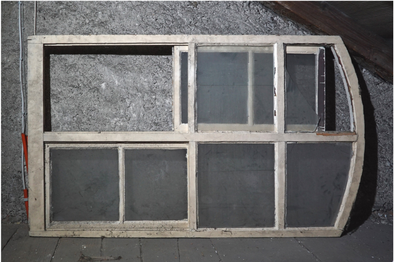
Auf dem Dachboden gelagertes früheres Vorfenster, Außenseite
