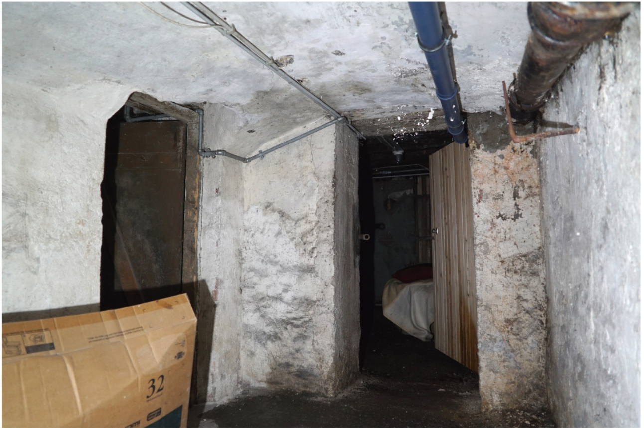
Linker Eingang, Keller: stichbögig gewölbter kleiner Raum, durch später angelegte Durchgänge 9 zum Vorkeller umgenutzt
