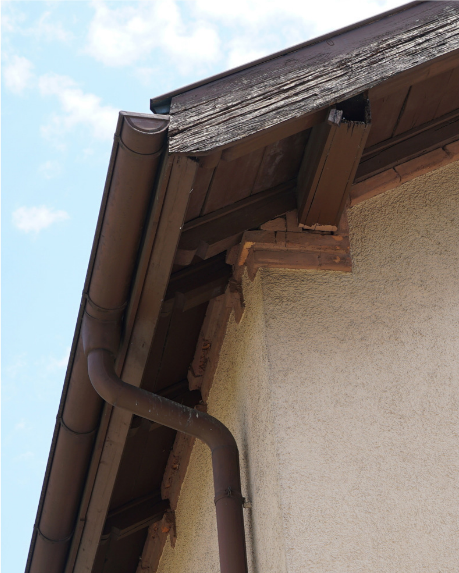
Traubereich an der Nordwestecke mit Konsolen aus Backstein 3 unter Kragsschwelle und Dachhölzern
