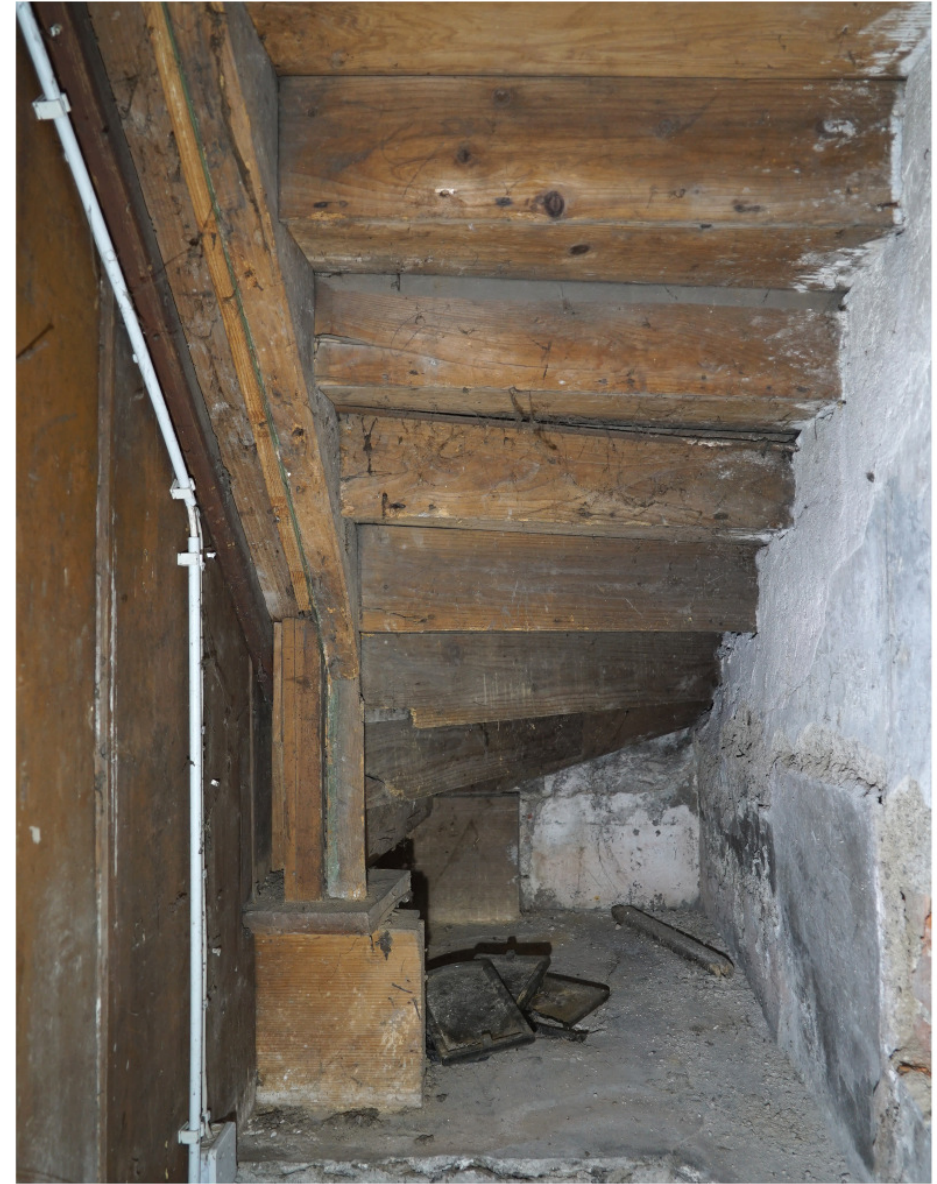
Wie Abb. 5, Untersicht, sichtbar von der Kellertreppe
