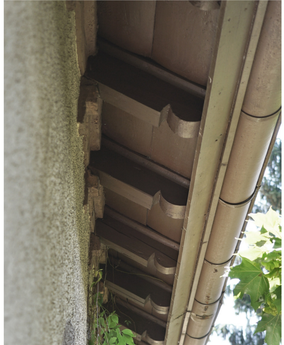
Profiliert ausgeschnittene Vorsprünge der Dachhölzer hinter 4 später angebrachtem Traufbrett
