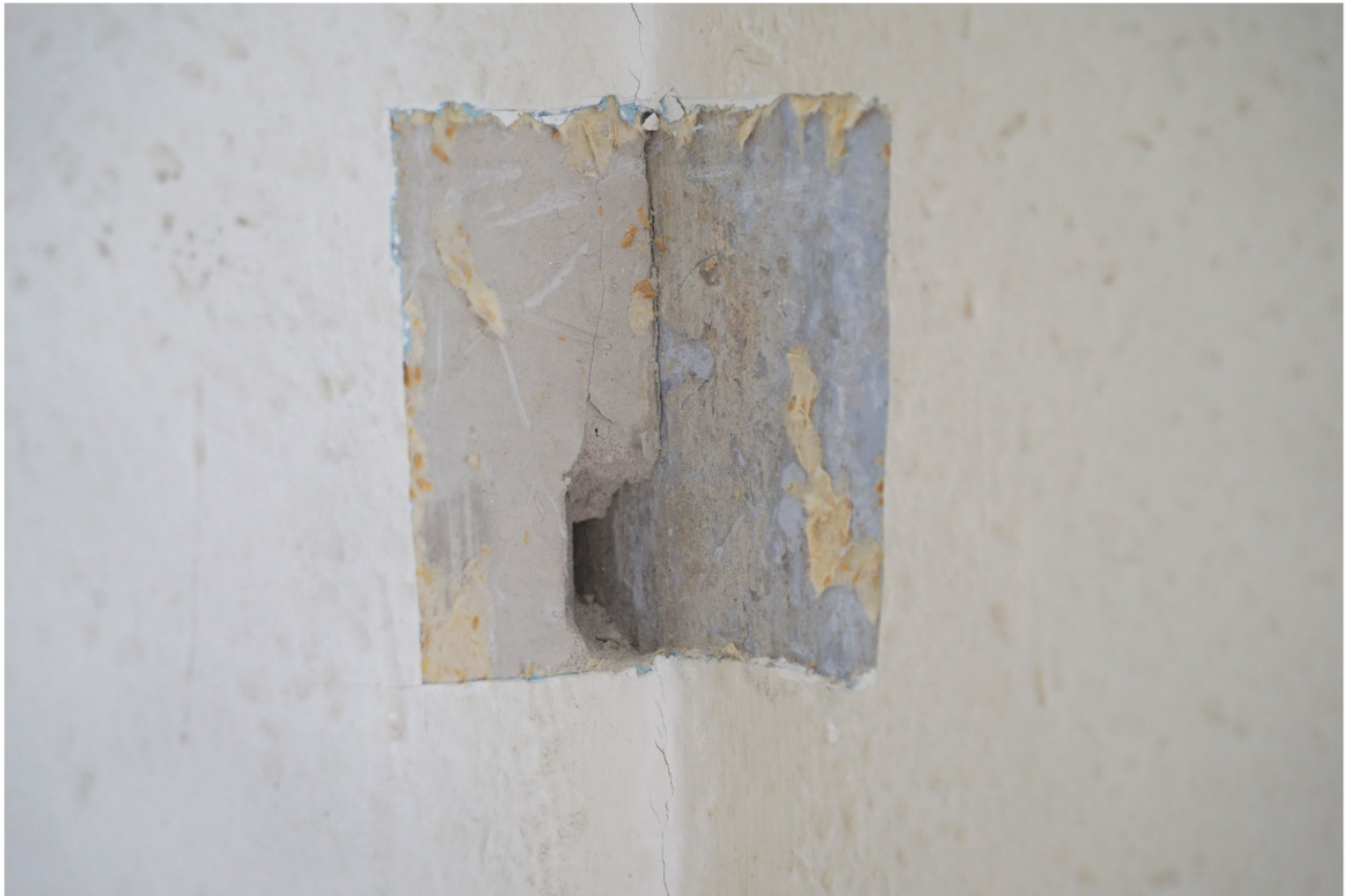
Rechter Eingang, Wohnung im Obergeschoss links: Sondage zum stumpfen Stoß einer Querwand gegen hellblaue Fassung der rückwärtigen Traufwand
