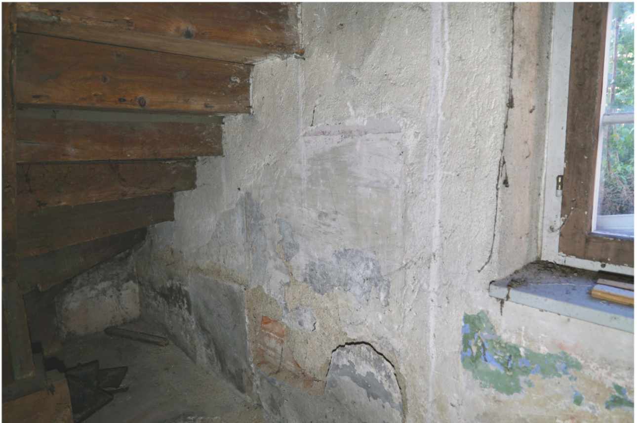
Treppe linker Eingang, Erdgeschoss: Reste von Wandfassungen unterhalb der Treppe von einst zwei getrennten Räumen
