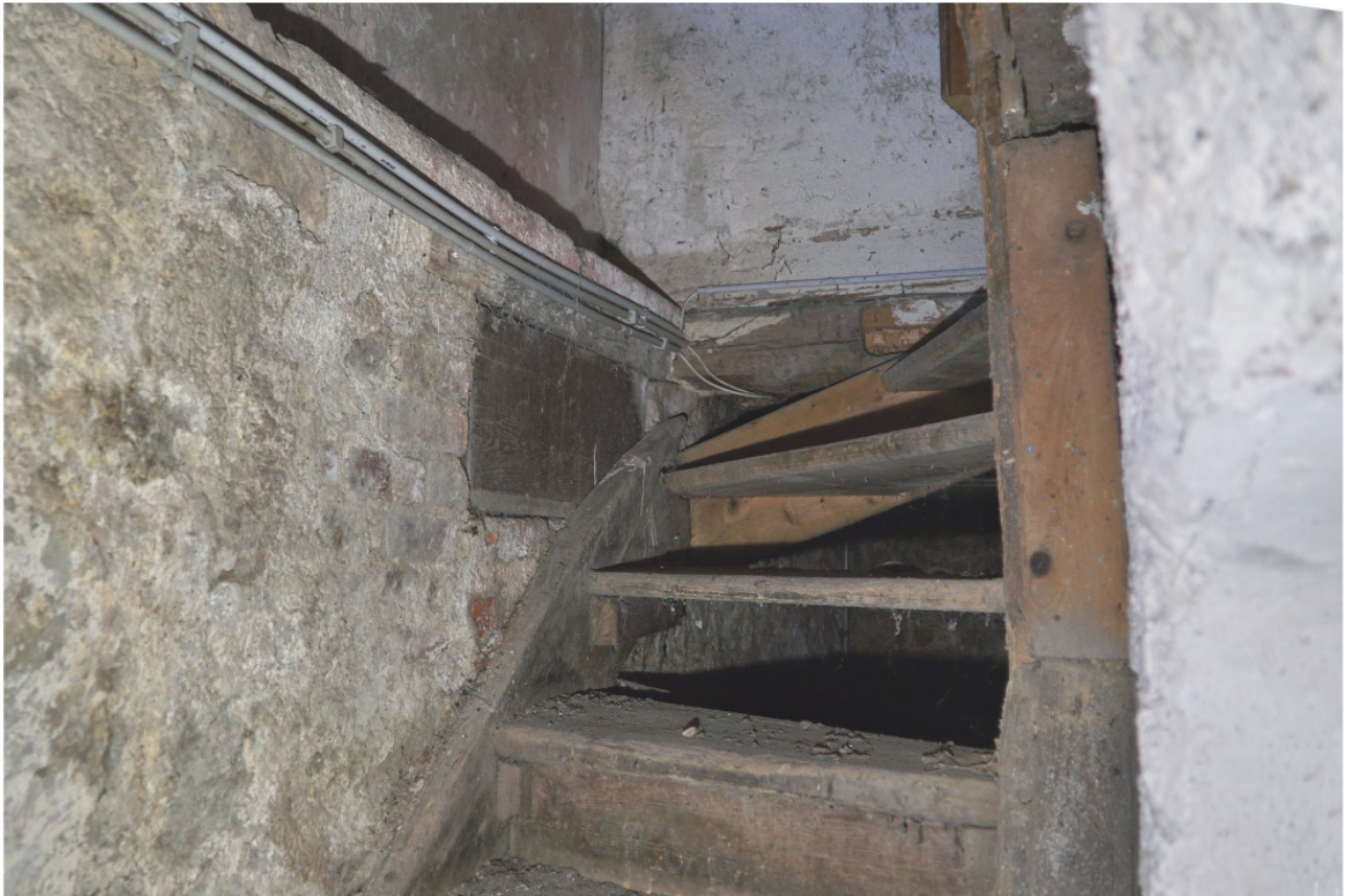
Linker Eingang, Keller: Kellertreppe vor einstigem, mit einem Brett verschlossenen Kellerfenster 11
