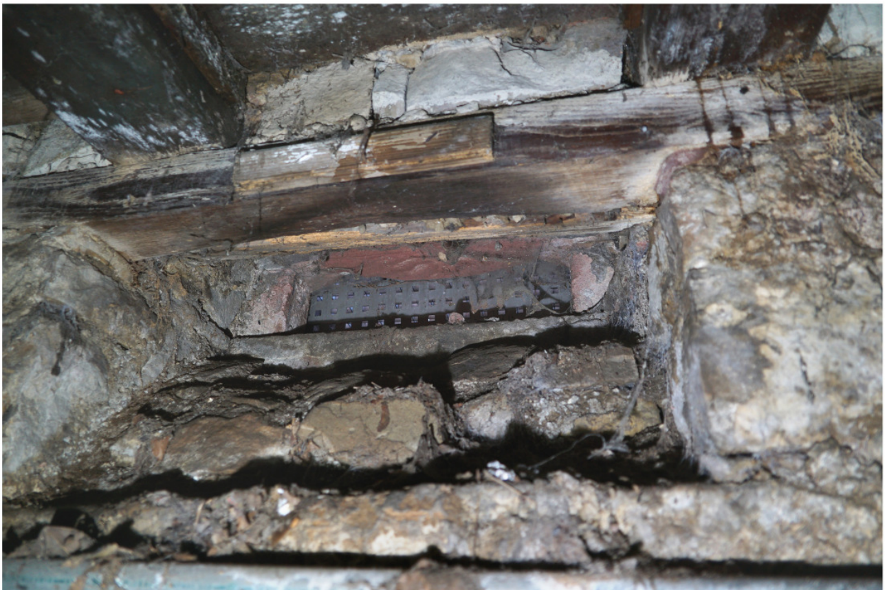
Linker Eingang, Keller: Kellerfenster zur vorderen Traufseite mit Werksteingewände, auf Höhe der Mauerschwelle des Deckengebälks gelegen 12
