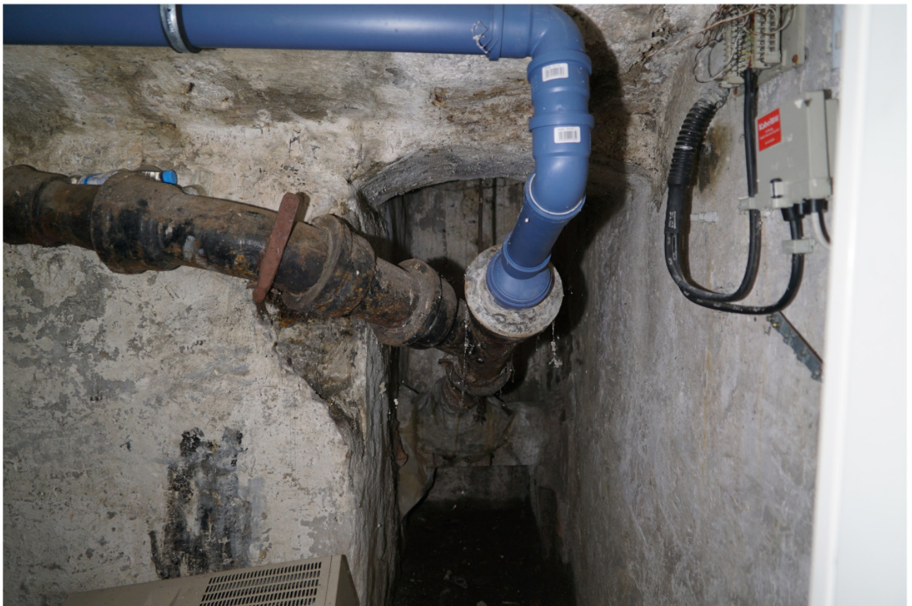
Wie Abb. 9, nach Norden verlaufender schmaler Schacht mit Entwässerung in ein quer 10 verlaufendes Abwasserrohr
