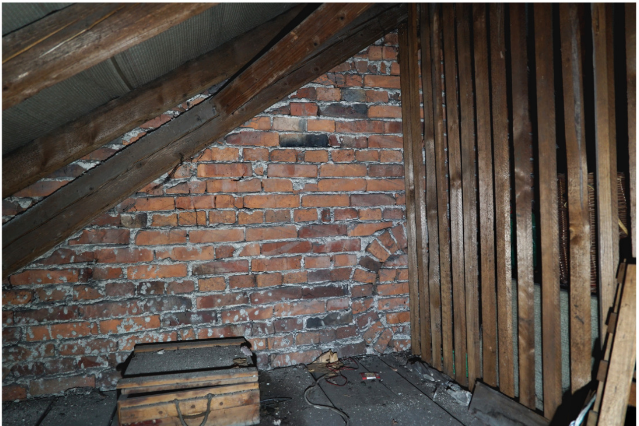
Innenseite des westlichen Giebel dreiecks mit Mauerung eines zentralen Okulus, der als bloßes Ornament schon bauzeitlich zugesetzt wurde
