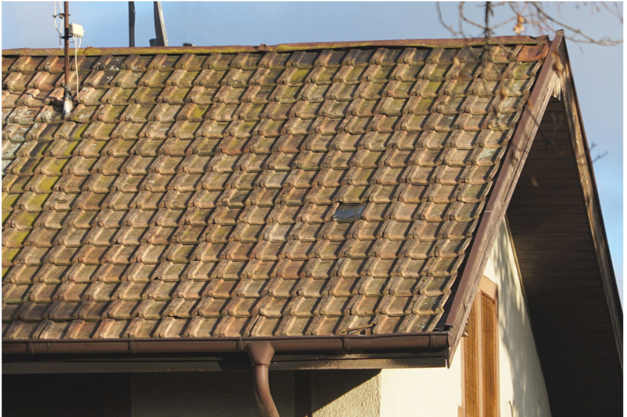
Falzziegeldeckung mit vereinzelt Glasziegel, verblechtem Ortgangbrett und Firstausbildung aus Blech
