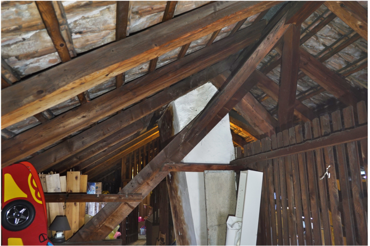
Dachwerk mit steiler gestellten Firststreben
