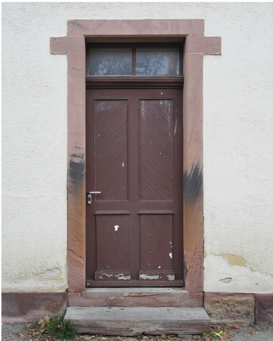
Türöffnung an der vorderen Traufseite in den nördlichen Erdgeschossraum mit bauzeitlichem Türblatt und Oberlicht
