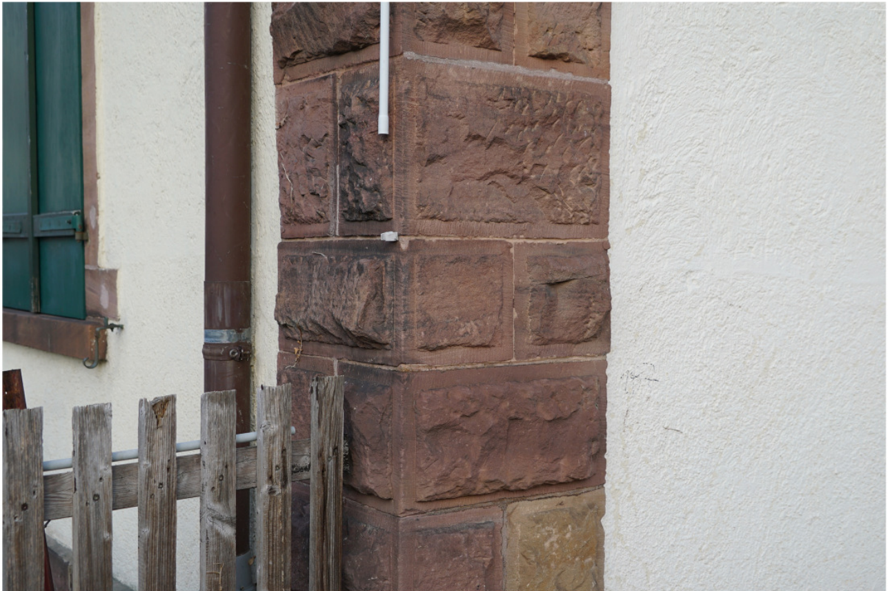
Eckbetonung durch Rustikaquader in Lisenenform mit variierenden Lagenhöhen und Bindern von der halben Breite der Läufer, Südwestecke
