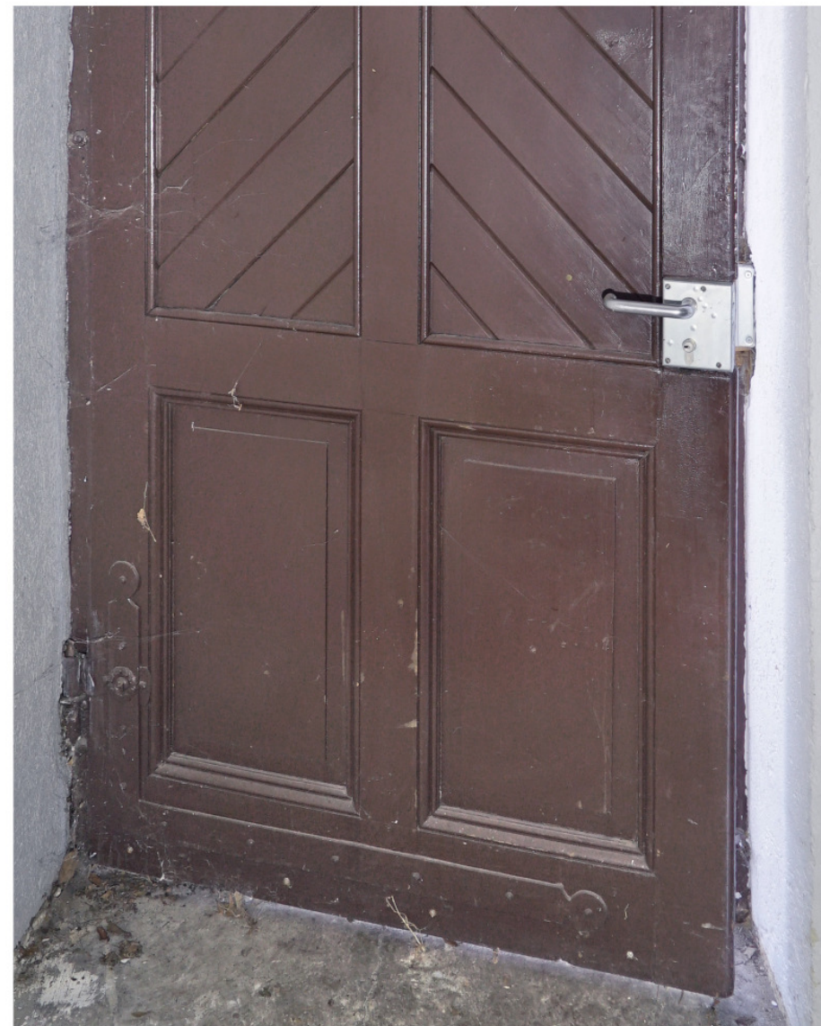
Wie Abb. 3, Innenseite mit Beschlag und profilierter Kassetierung im Brüstungsbereich
