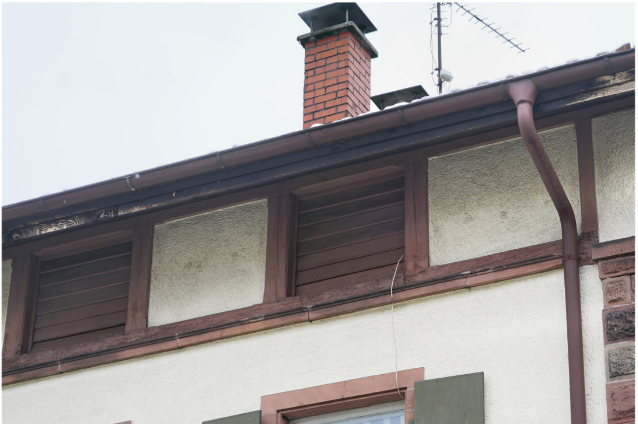
Lüftungsöffnungen im Drempel des Dachgeschosses mit beweglichen Jalousielamellen
