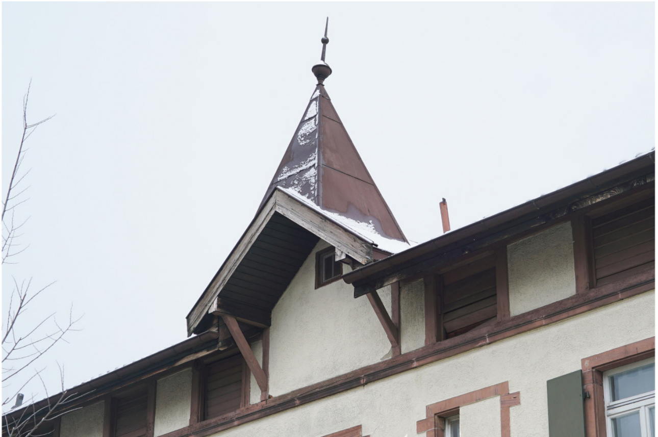
Zeltdach über Zwerchhaus in der Mitte der westlichen, rückwärtigen Längsseite mit Blechdeckung und Knauf
