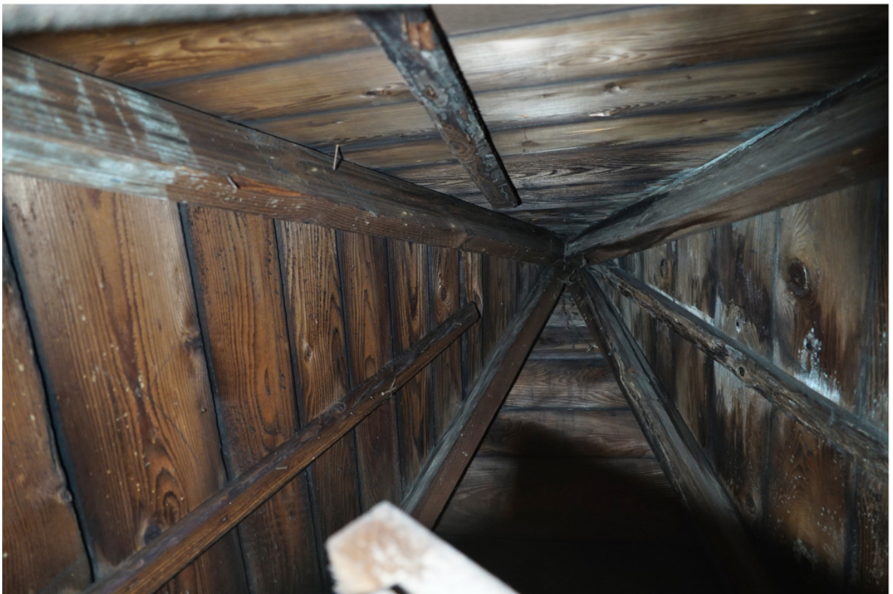
Wie Abb. 13, Blick ins Innere, Aufbau aus vier Gratsparren mit Bretterschalung und stabilisierend eingegelten Latten
