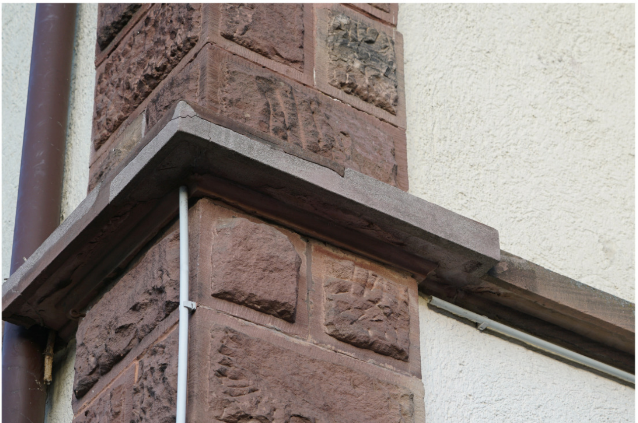
Wie Abb. 1, umlaufendes Stockwerksgesims mit untersetziger Tropfkante und Profilleiste sowie umfangreichem Anstrich mit Reparaturmörtel
