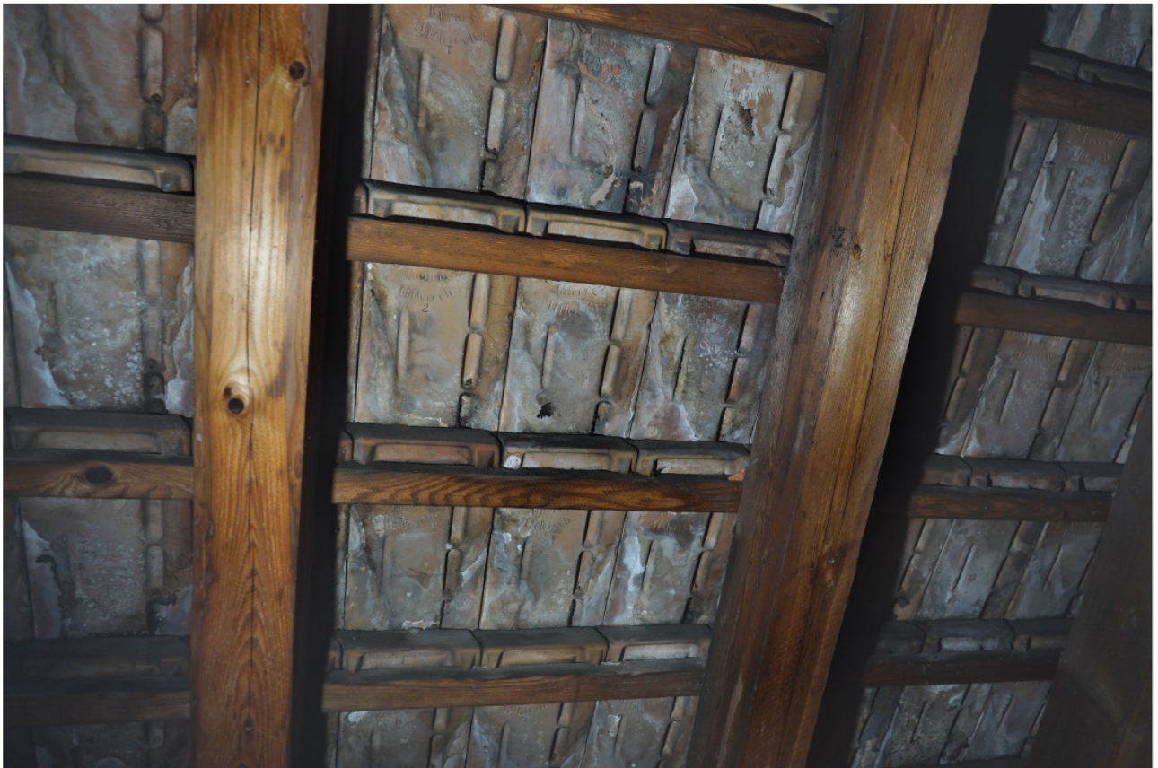
Falzziegeldeckung von der Innenseite mit Stempel der Ziegelei
