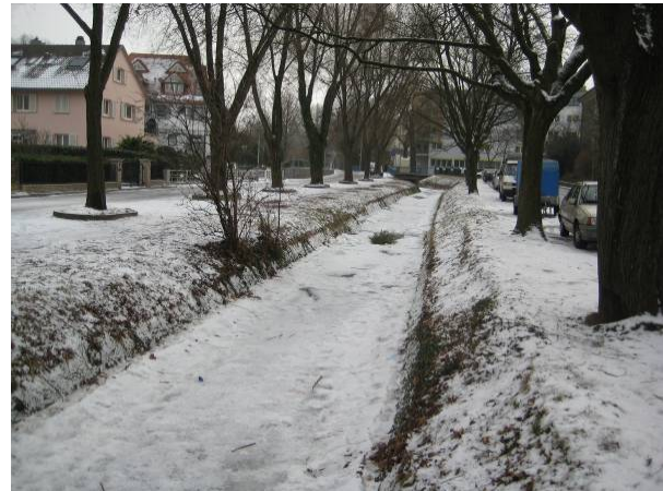
Naturferner, unzugänglicher Abschnitt des Dorfbachs zwischen Markgrafen- und Staufener Straße
