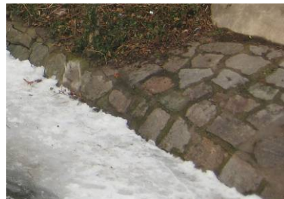
verbauter Böschungfuß (Brücke an der Markgrafenstraße)
