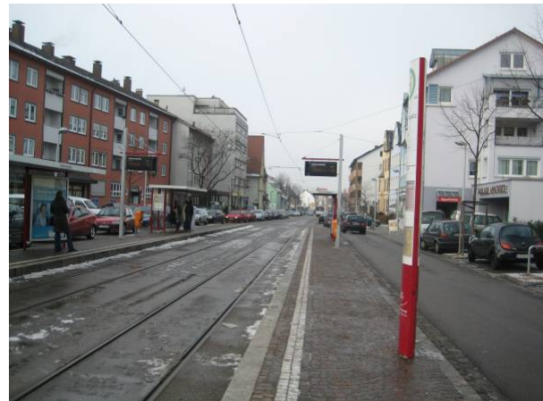
Blick entlang der Carl-Kistner-Straße; wichtige Versorgungsfunktionen, aber beengte Verhältnisse, kein einheitliches Straßenbild.
