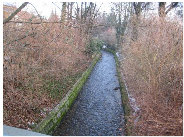
Kronenmühlbach westlich der Markgrafenstraße: kaum Gewässerstrukturen und geringe Attraktivität trotz dichtem Bewuchs; unzugänglich
