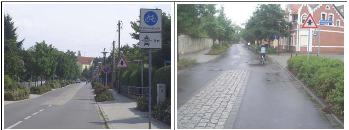
Bild 7-11: Beispiel Senftenberg Optische Einengung der Fahrbahn durch Großpflaster in der Fahrbahnmitte
