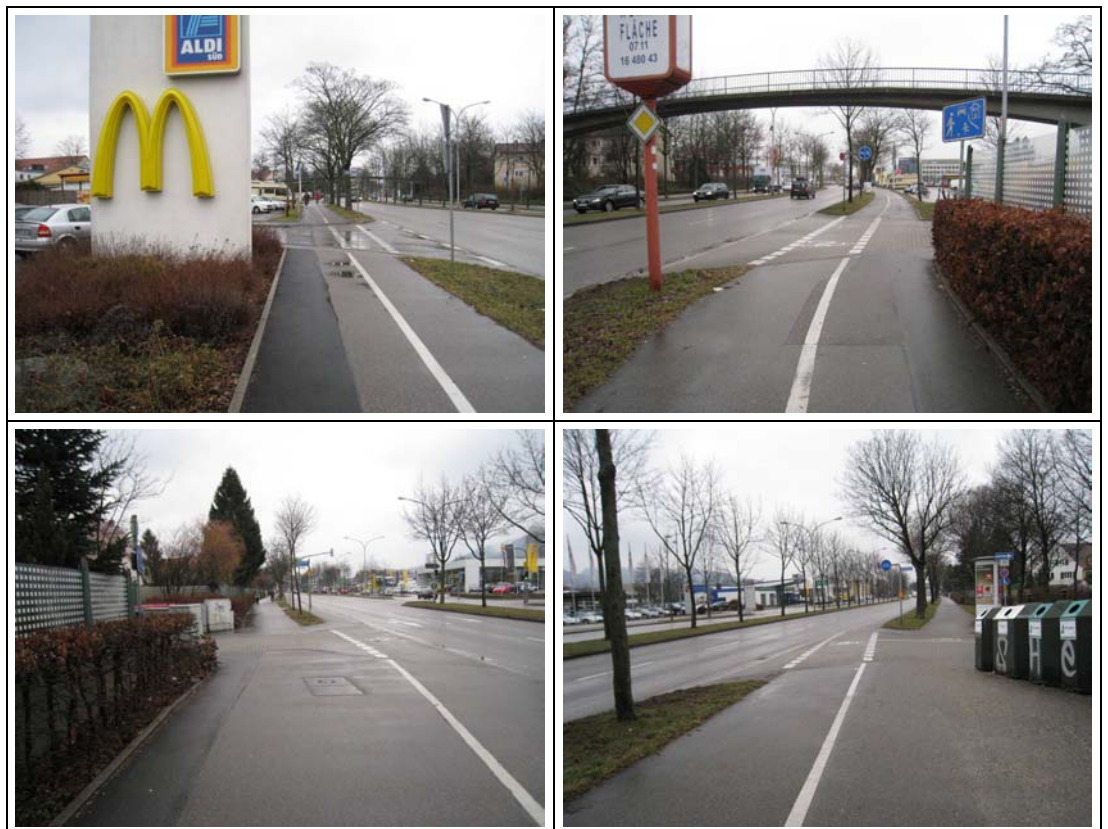
Bild 9-2: Sichtbehinderung an den Einmündungen
