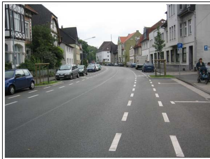
Bild 4-1: Gestaltung eines Straßenraums mit Schutzstreifen, Parkständen und Gehwegnasen. Beispiel Lemgo
