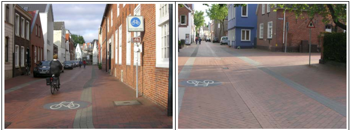
Bild 7-9: Beispiel Leer Besondere Pflasterkombination und Piktogramm mit Wiedererkennungswert Piktogramme in Blau (in Anlehnung an Verkehrszeichen)
