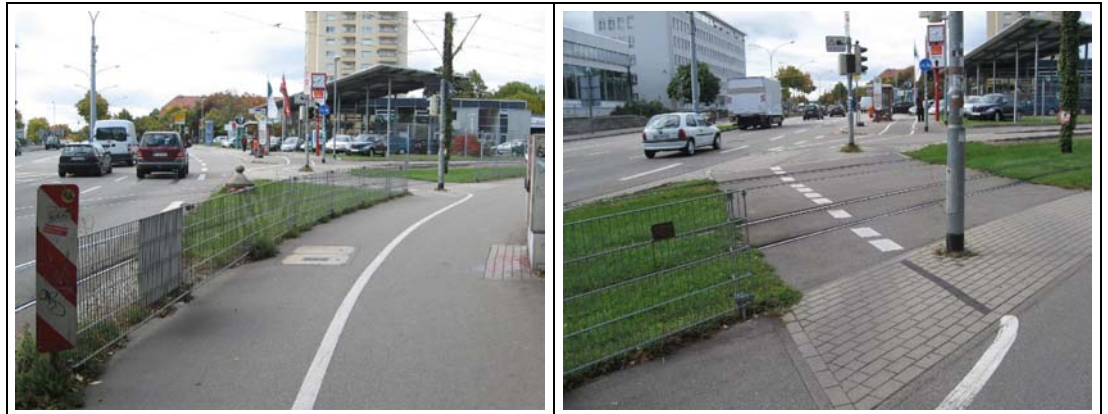
Bild 9-5: Radfahrerfurt über die ÖPNV-Trasse zur Eschholzstraße
