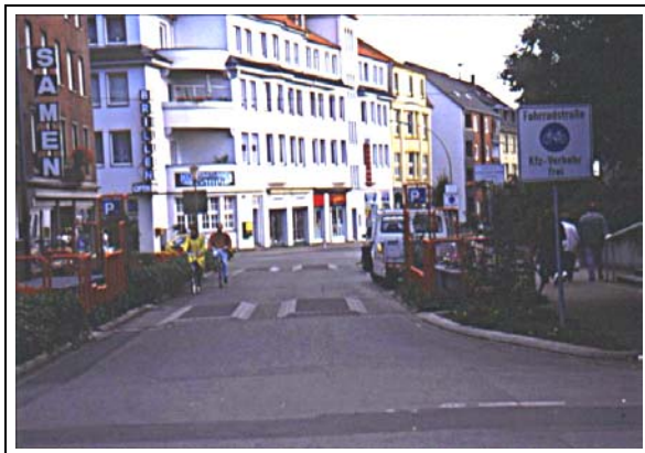
Bild 7-14: Beispiel Gladbeck Punktueller Aufpflasterung zur Geschwindigkeitsreduzierung (Radfahrer können die Kissen ohne Behinderung passieren)
