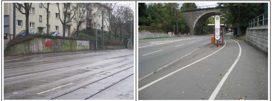
Bild 9-9: Parkbucht und ungünstig gelegene Bushaltestelle im südlichen Seitenbereich des Abschnittes
