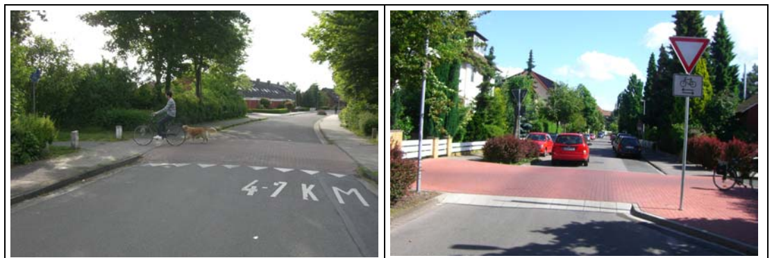
Bild 8-4: Beispiele bevorrechtigter Radwege aus Leer (Foto links) und Lehrte (Foto rechts)
