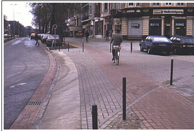
Bild 9-4: Beispiel Bremen: Gestaltung einer Einmündung mit durchgehendem Radwegebelag und optischer Unterbrechung durch schmalen Plasterstreifen
