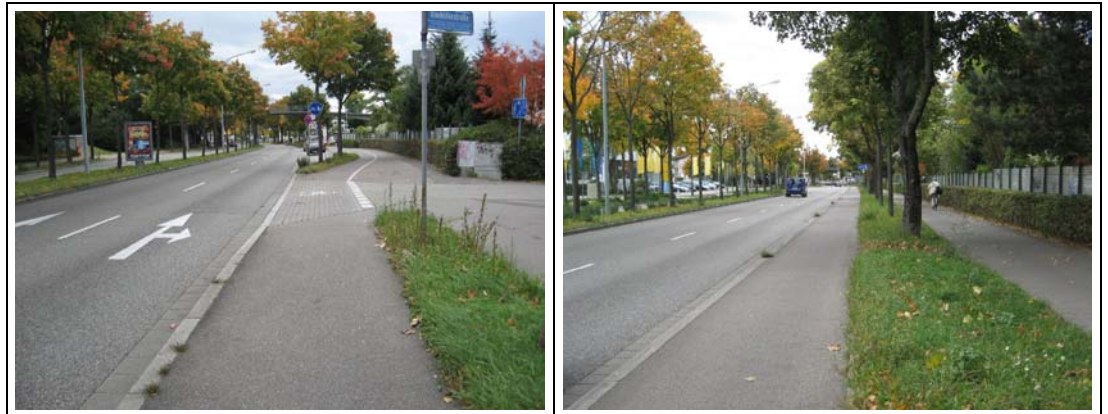
Bild 9-1: Fehlende Querungs- und Ausweichmöglichkeiten im nördlichen Seitenbereich
