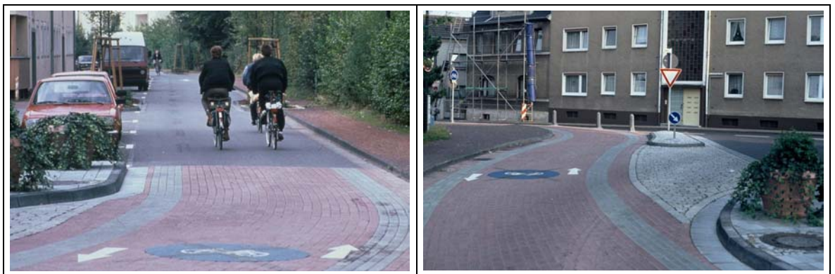
Bild 7-12: Beispiel Troisdorf Pflasterkombination Piktogramme in blau mit Richtungspfeilen
