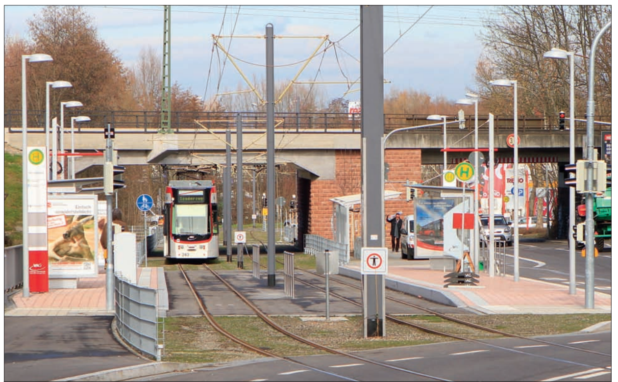
Der Einschub des neuen Brückenteils (oben) geriet im September 2012 zum Spektakel. Die neue Durchfahrt schafft viel Platz für die Stadtbahn sowie einen Fuß- und Radweg.
