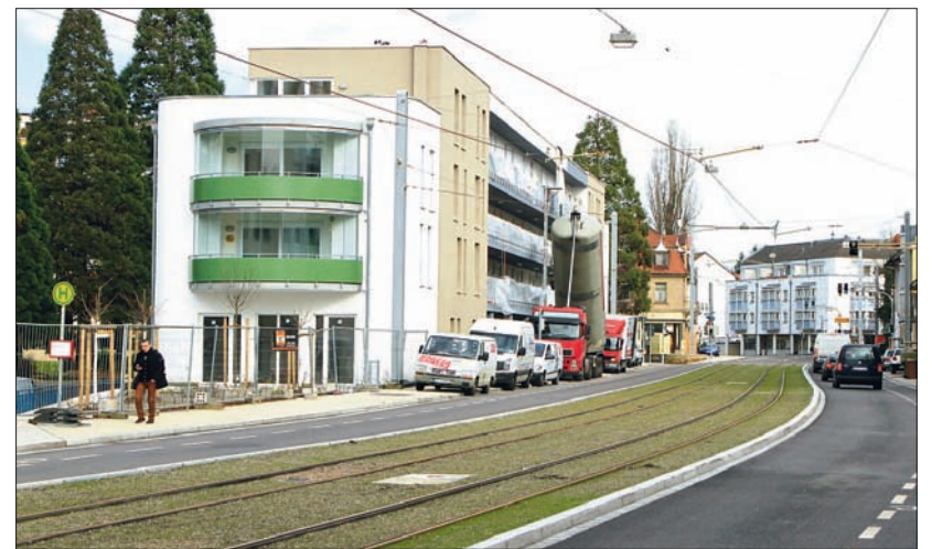
Kaum wiederzuerkennen ist die Zähringer Straße, wie diese Vergleichsaufnahmen vor Baubeginn und nach der Fertigstellung zeigen. Endlich gibt es für alle Verkehrsarten ausreichend Platz. (Foto oben: A. Schödel)
