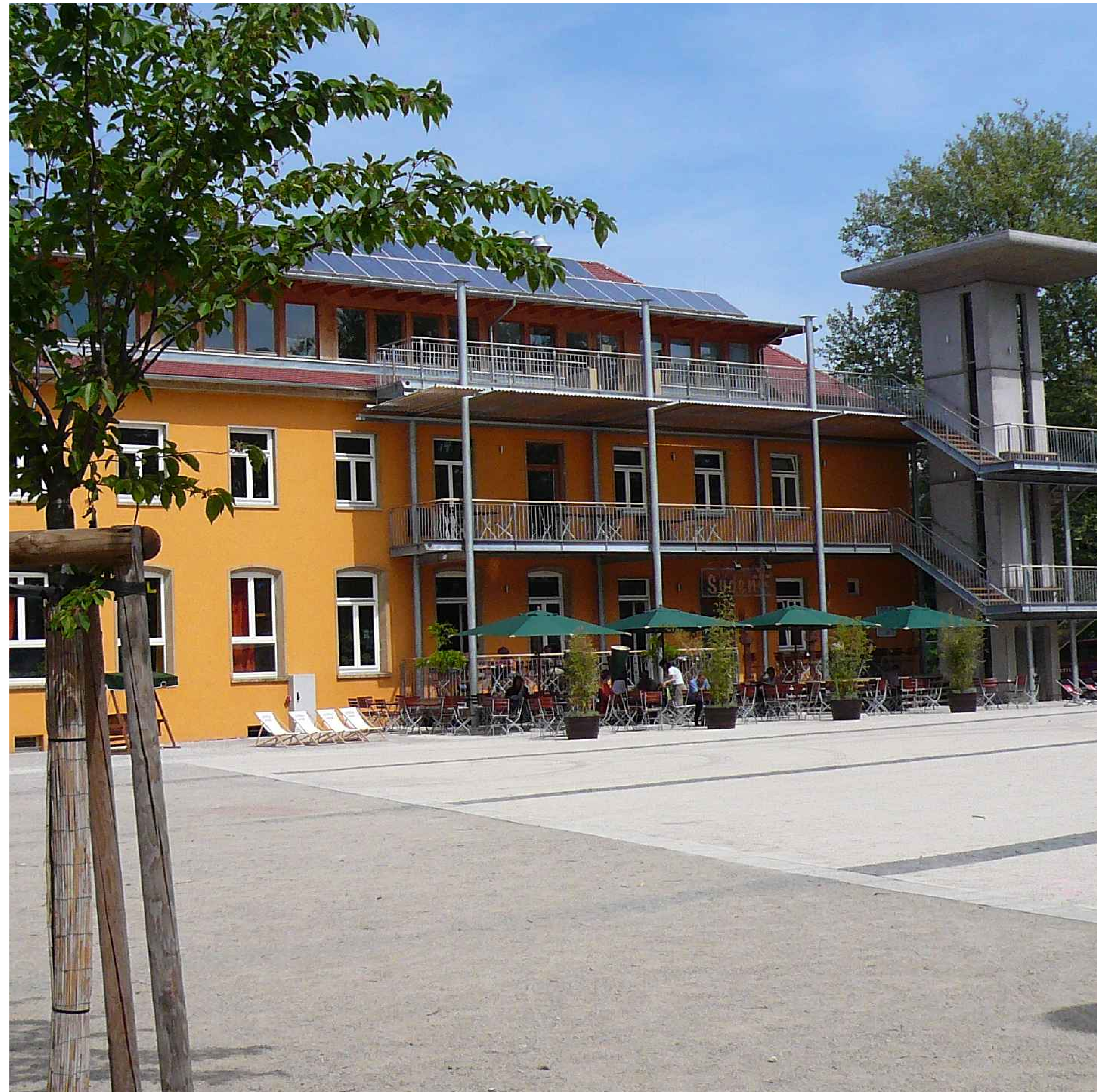
Alfred-Döblin-Platz / Bürgerhaus - Community centre
