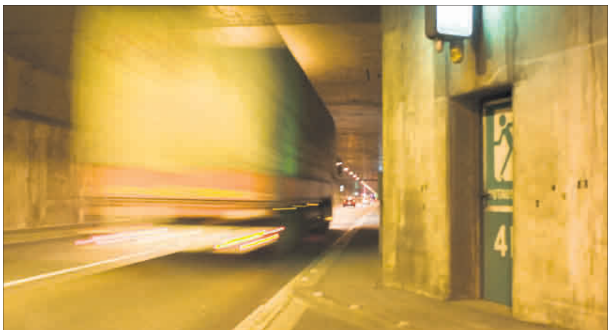
Durchgangsverkehr unter die Erde: Das wichtigste Straßenbauprojekt des VEP ist der Bau des Stadttunnels. (Foto: M. Spiegelhalter)
