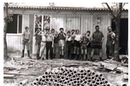
Bau des ersten Vereinsheims 1908
