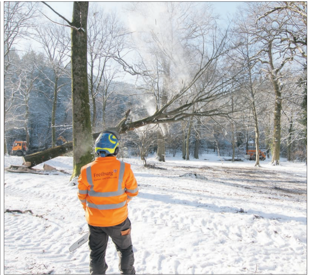
Rund 70 Bäume, darunter auch diese Altbuche, entfernten die städtischen Arbeiter in den vergangenen Tagen. (Foto: A. J. Schmidt)
