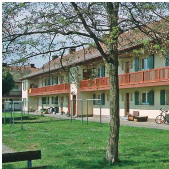
Laubenhof vor der Sanierung (2002)
