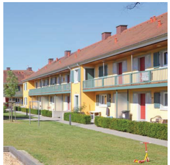
Neu saniert im ursprünglichen Stil (2008)
