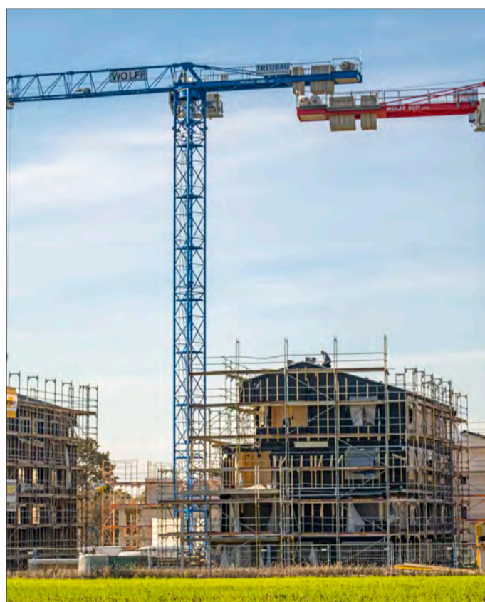
Hoch hinaus: Die neue Bebauung am Ebnet Ortsrand schafft dringend benötigten Wohnraum, gefällt aber wegen der Bauhöhe nicht allen. (Foto: P. Seeger)
