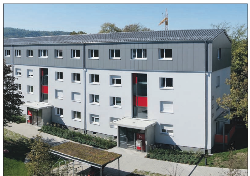
Nachverdichtung in Haslach: Erstmals in ihrer Geschichte ist es der Freiburger Stadtbau im letzten Jahr gelungen, durch Aufstockung einer Etage 24 neue Wohneinheiten zu schaffen. Dies wird allerdings eine seltene Ausnahme bleiben, denn unüberwindbar sind oft die baurechtlichen und statischen Probleme. Die Potentiale sind begrenzt. (Foto: A. J. Schmidt)
