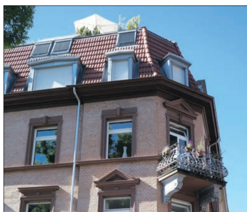
Schön, aber teuer: Dachausbau ist weder förderfähig, noch entsteht hierdurch im Quartier zusätzliche Infrastruktur. (Foto: Stadt Freiburg)
