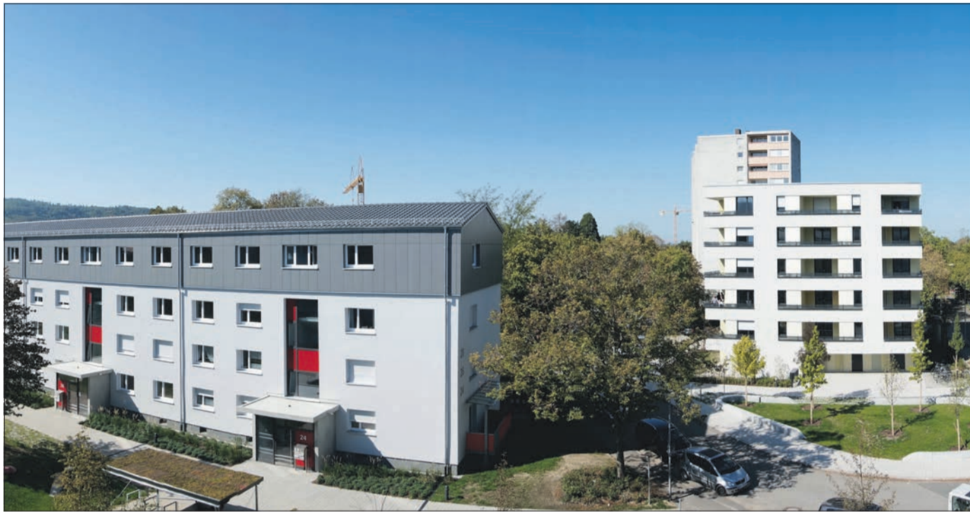
Blick in die Belchenstraße: Auf der linken Seite der modernisierte Gebäuderiegel mit gut erkennbarer Aufstockung. Auf der rechten Seite sieht man das neue Punkthaus der Belchenstraße 10 und direkt dahinter das zum Abriss bestimmte Hochhaus Belchenstraße 8. (Foto: A. J. Schmidt)
