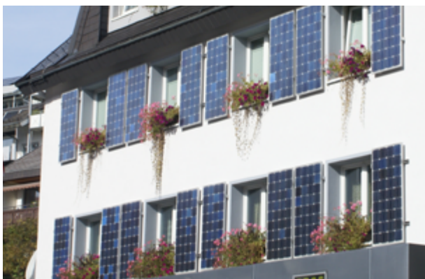
Photovoltaik an der Fassade (Bild: Energieagentur Regio Freiburg)
