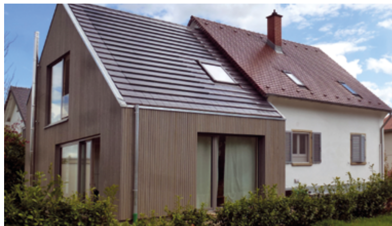
Photovoltaik als Dachintegration (Bild: Sigma Energy Systems GmbH)
