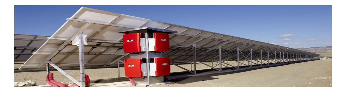
Sobald die Temperatur der gefährdeten Bauteile unter den kritischen Wert sinkt, steuert der Wechselrichter wieder den optimalen Arbeitspunkt an. Temperatur-Derating kann aus unterschiedlichen Gründen auftreten, z.B. wenn PV-Generator und Wechselrichter ungünstig aufeinander abgestimmt sind oder die Installationsbedingungen die Wärmeabfuhr des WR behindern.
