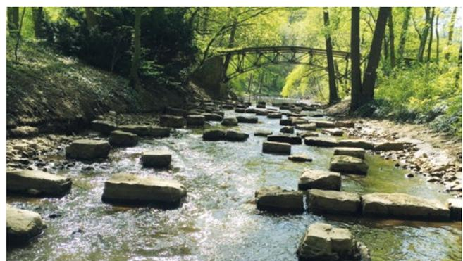
Bild 6: Fertig gestellte Sohlengleite im Betrieb
