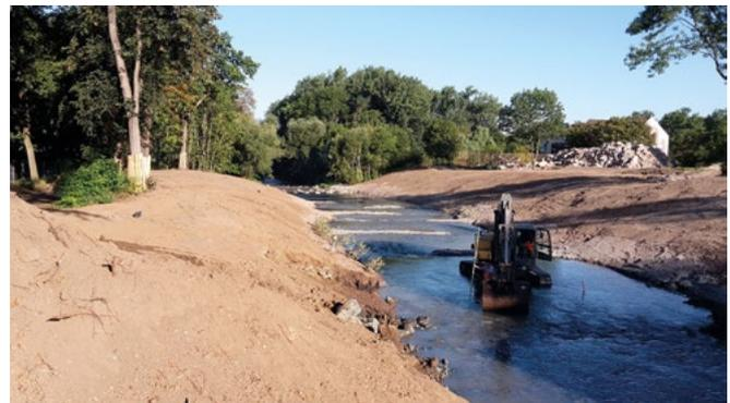
Bild 7: Gewässerausbau und Bau der Sohlgleite im Bereich der alten Wehranlage (Foto: Franka Ludwig)
