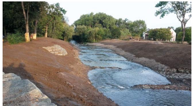
Bild 14: 2016 Fertigstellung des unteren Abschnitts der Sohlgleite am ehemaligen Wehrstandort (Foto: Klaus Böhm)
