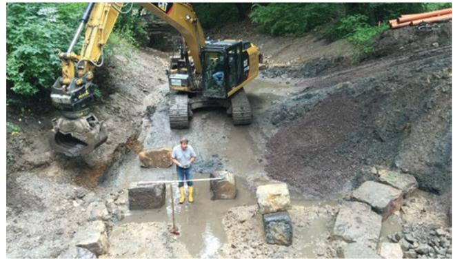
Bild 3: Setzen der Steinriegel (Foto: R. Rochell, SBM)
