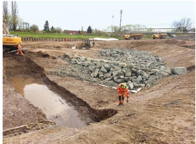
Bild 6: Bau Flussschlinge und Anlage von Riegeln für die Sohlgleite (Foto: Franka Ludwig)
