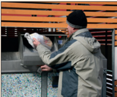
Müllschleuse in Freiburg
