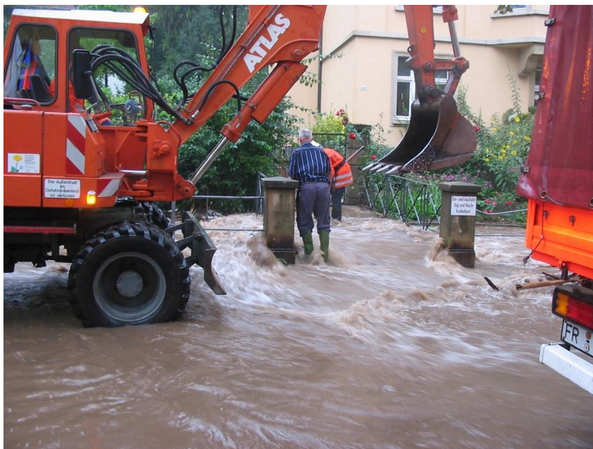
Abbildung 1.1 Hochwasser Wiehre 18.09.2006, Bereich Schwimmbadstraße
