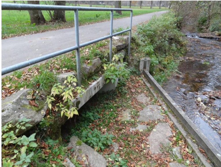
Abbildung 5.7 Bestandssituation Zulauf Graben 2 (Beaufschlagung nur bei erhöhten Abflüssen)
