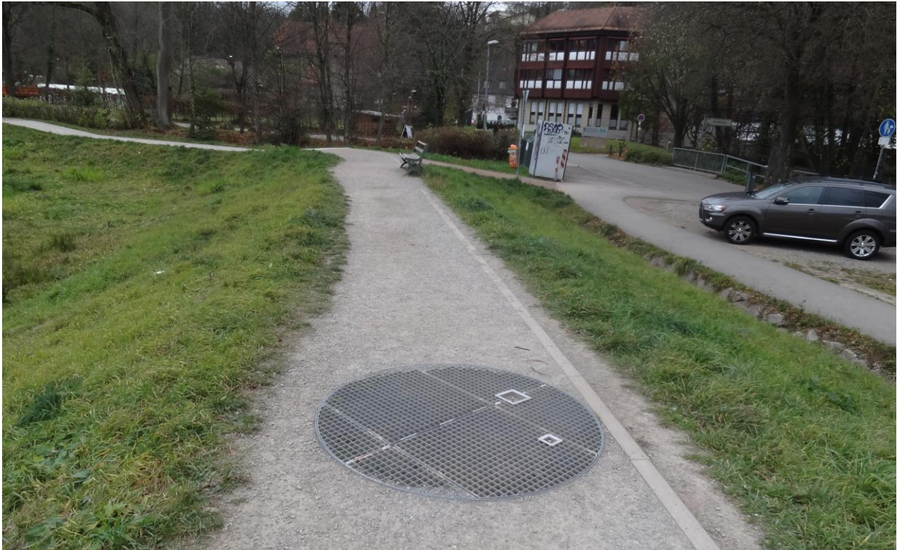
Abbildung 5.5 Bereich des geplanten Ausleitungsbauwerks im Bereich der Wonnhaldestraße
