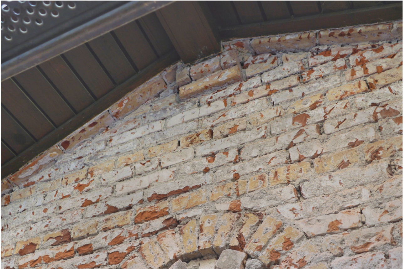
Nr. 76: nördliche Giebelseite mit vortretender Steinlage entlang des Ortgangs und gestuft vortretende Einfassung um die Firstschwelle, Ortgang mit jüngerer Verschalung
