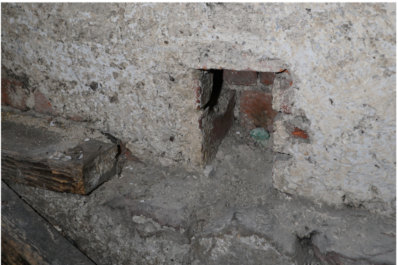
Nr. 70c: unterer Ansatz eines Lüftungsschachts neben der Kellertreppe, nach links Verbindung zur Öffnung des gegenüberliegenden Hauses, nur getrennt durch einen gestellten Backstein
