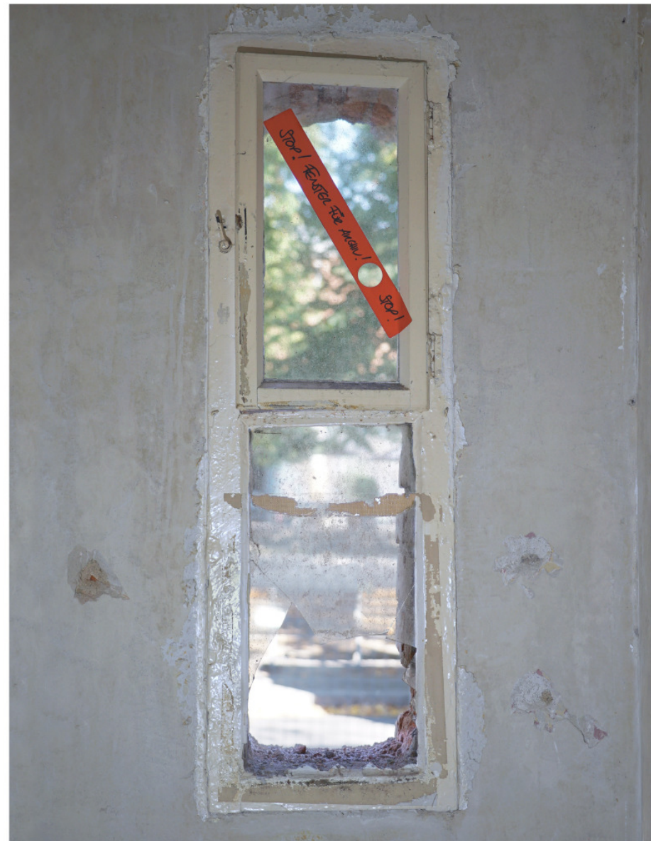
Nr. 76p: Abortfenster, Innenseite mit übergreifendem Flügel 18
