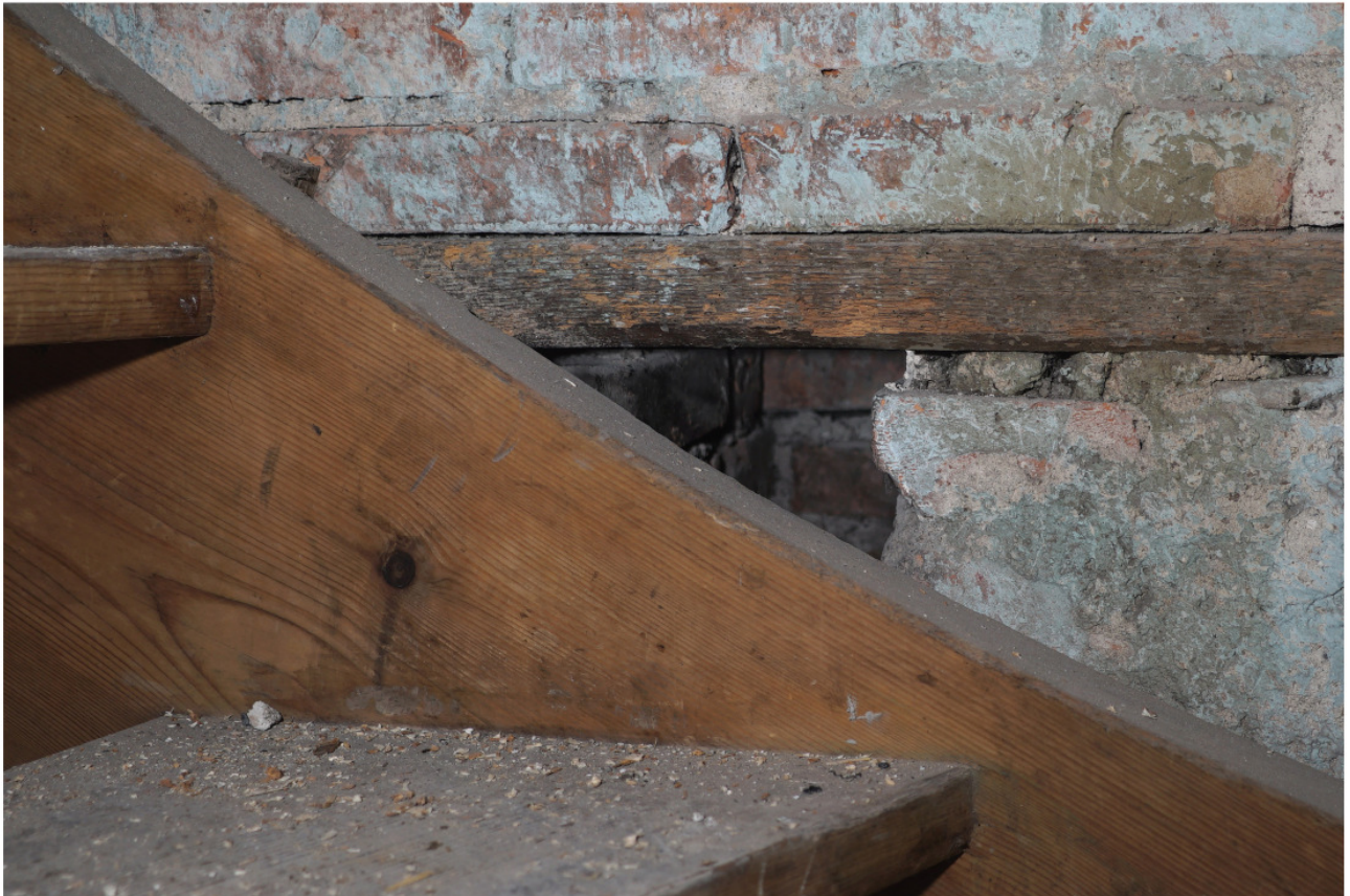
Nr. 76c: unterer Ansatz eines Lüftungsschachts unterhalb der Mauerschwelle, von der Treppenwange teilweise verdeckt
