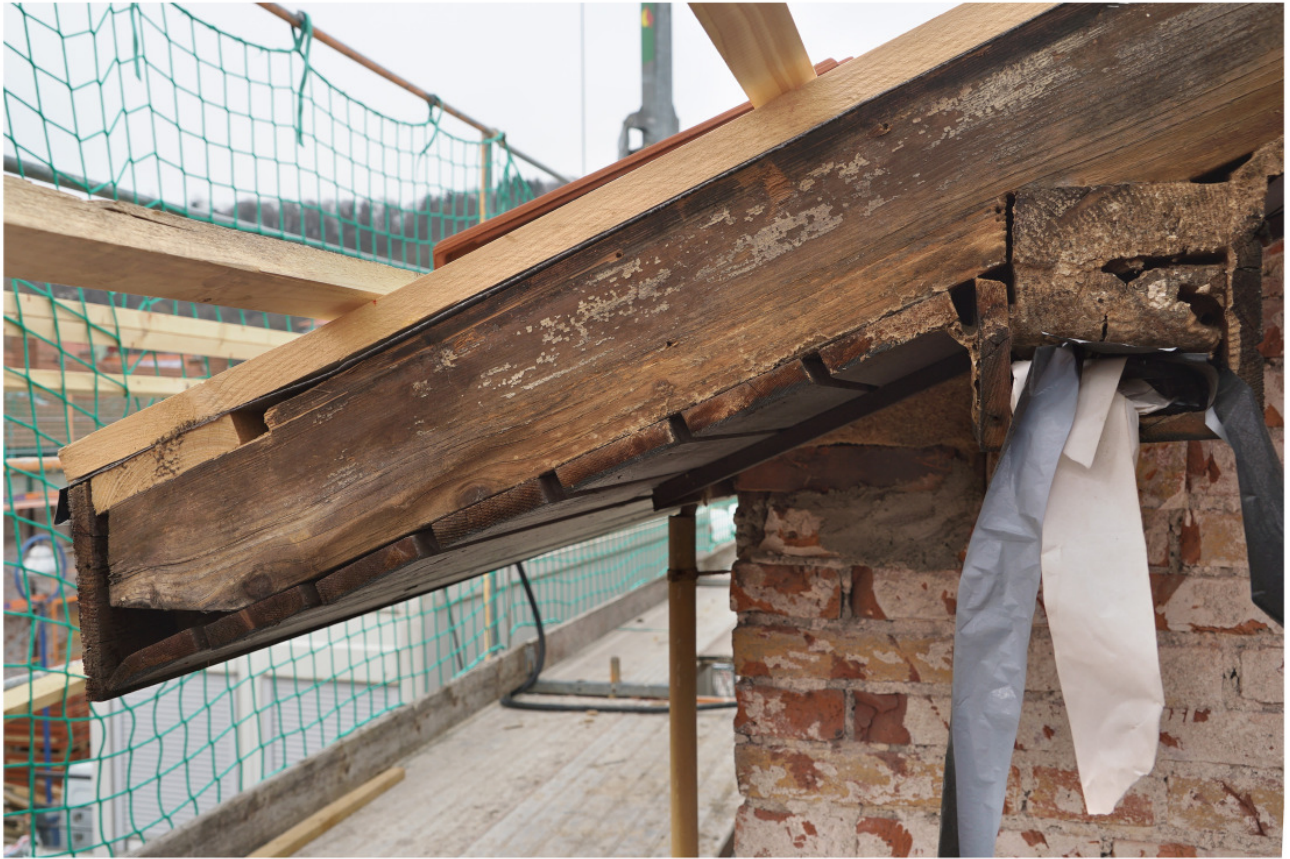
Nr. 76: Freisparren auf Vorkragung an der Südwestecke mit einfachen Abschnitten am Ende und ohne Fasen
