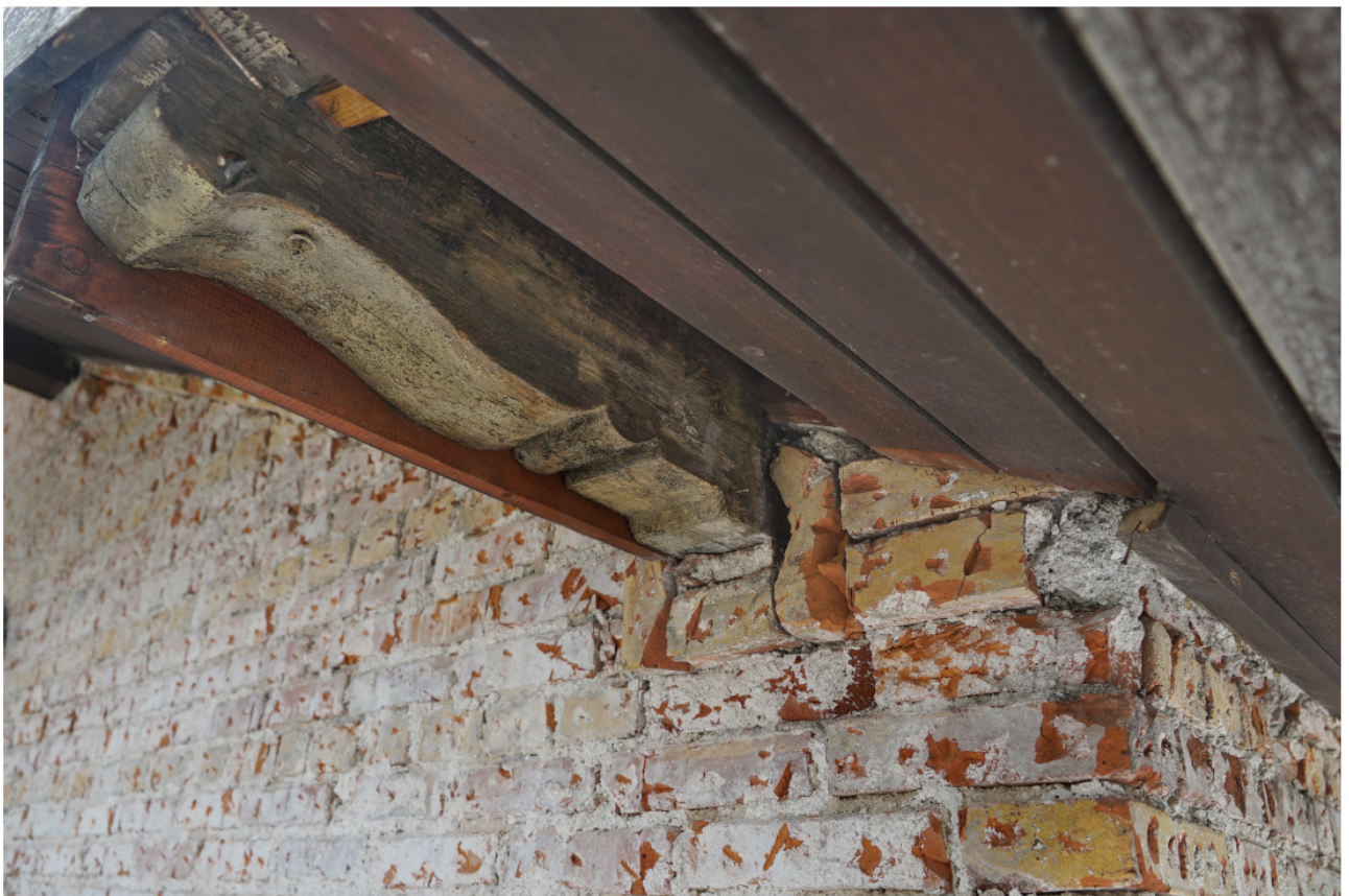
Nr. 70: vorkragende beschnittene Traufschwelle an der Nordwestecke mit vortretender Einfassung im Steinverband in Fortsetzung der traufseitigen Konsölchen, teilweise abgeschlagen
