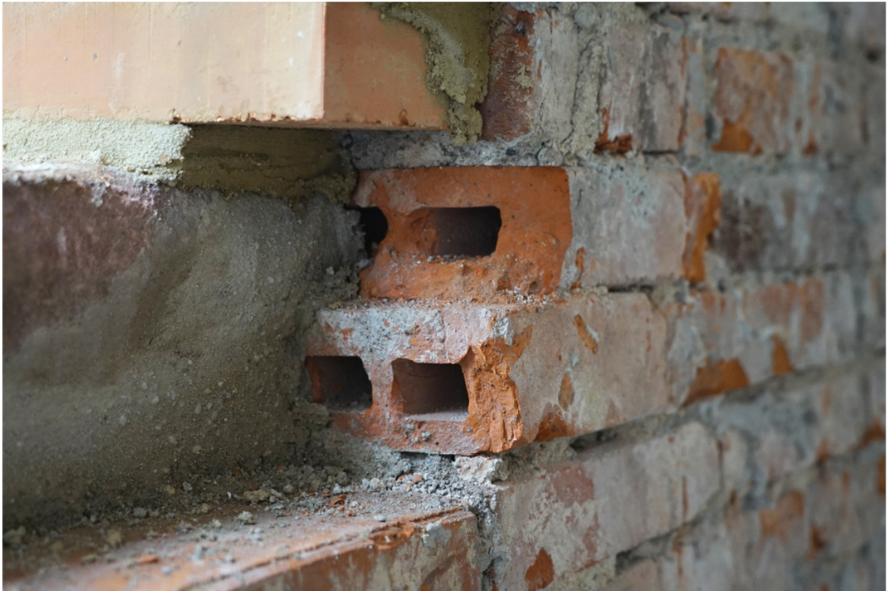
Nr. 76: Backsteine der innenseitigen Wandfläche mit jeweils zwei vierkantigen Längslöchern
