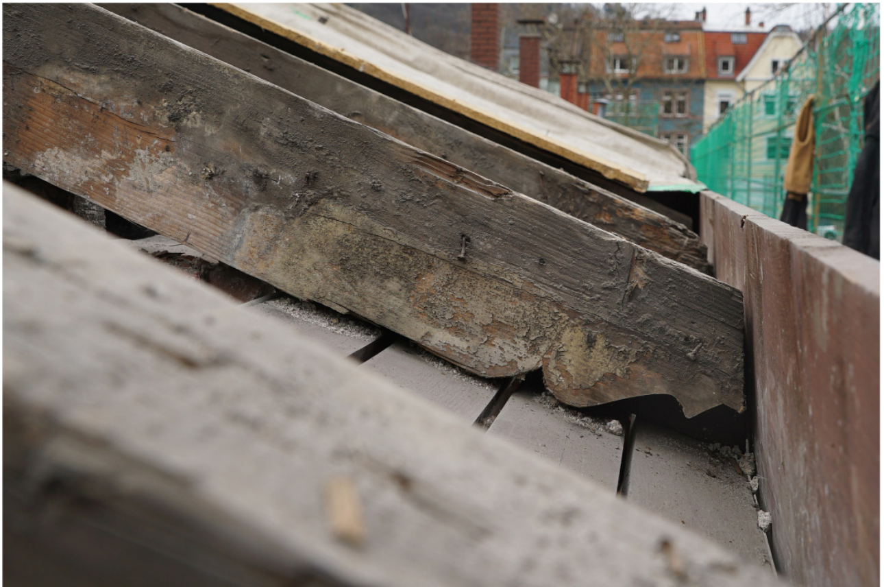
Nr. 76: beschnitztes Sparrenende der Osttraufe bei abgenommener Deckung und Lattung
