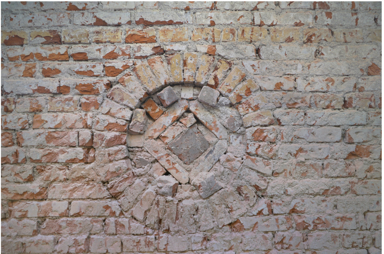
Nr. 76: Rosette im nördlichen Giebeldreieck mit Ockerfassung, Füllung aus einem über Eck gestellten Quadrat und spätere Ausstopfung für den Putzauftrag
