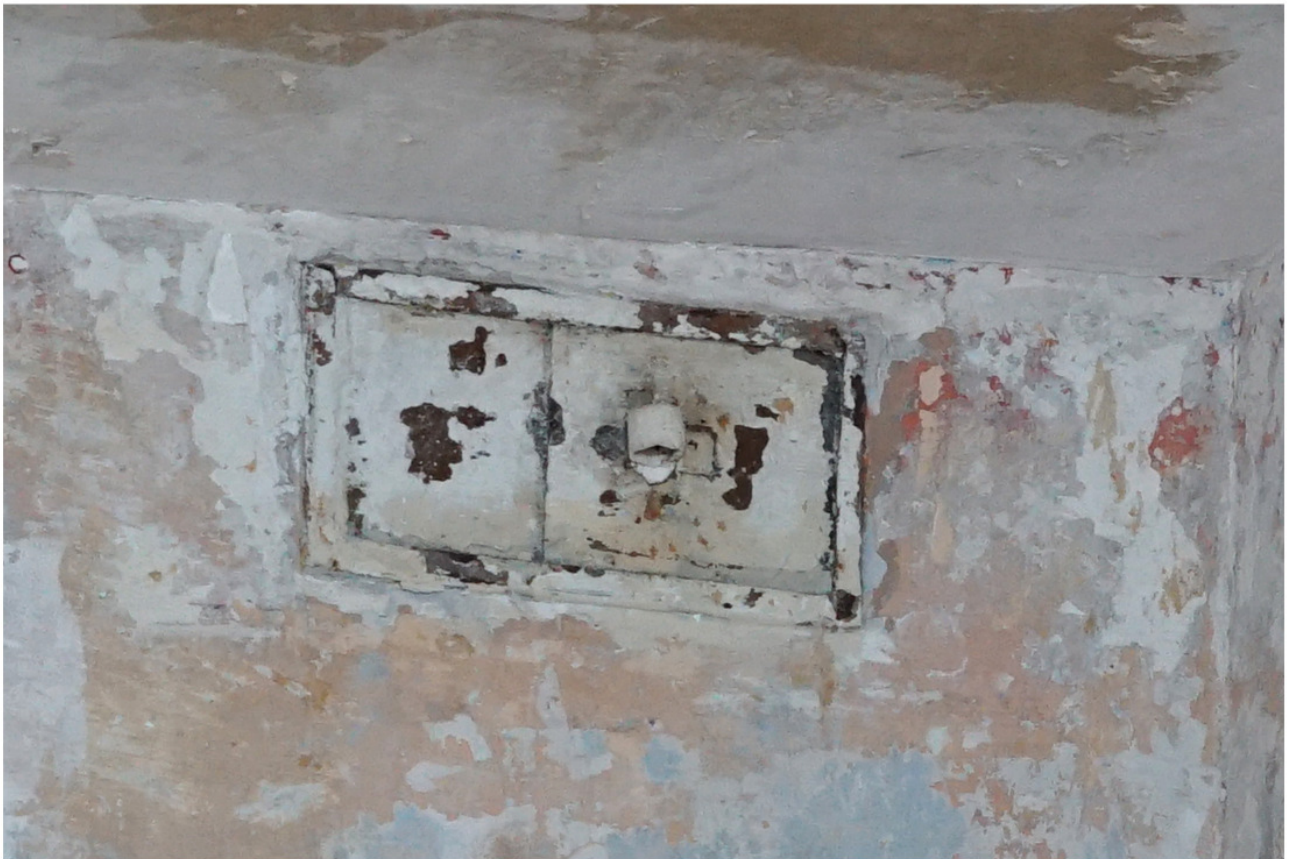
Nr. 76 h: Blechschieber zum Lüftungsschacht des Erdgeschossraums mit erhaltenem Griff
