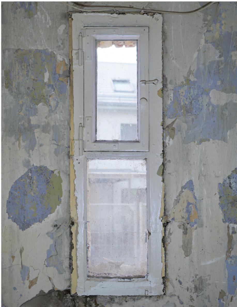
Nr. 70a: Abortfenster, Innenseite mit bündig versenktem Flügel 17
