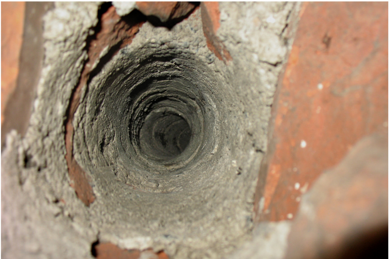
Nr. 70 c: Blick in einen Lüftungsschacht (die Kamera wurde in den oberen Austritt im Dachraum gehalten und nach unten gerichtet)
