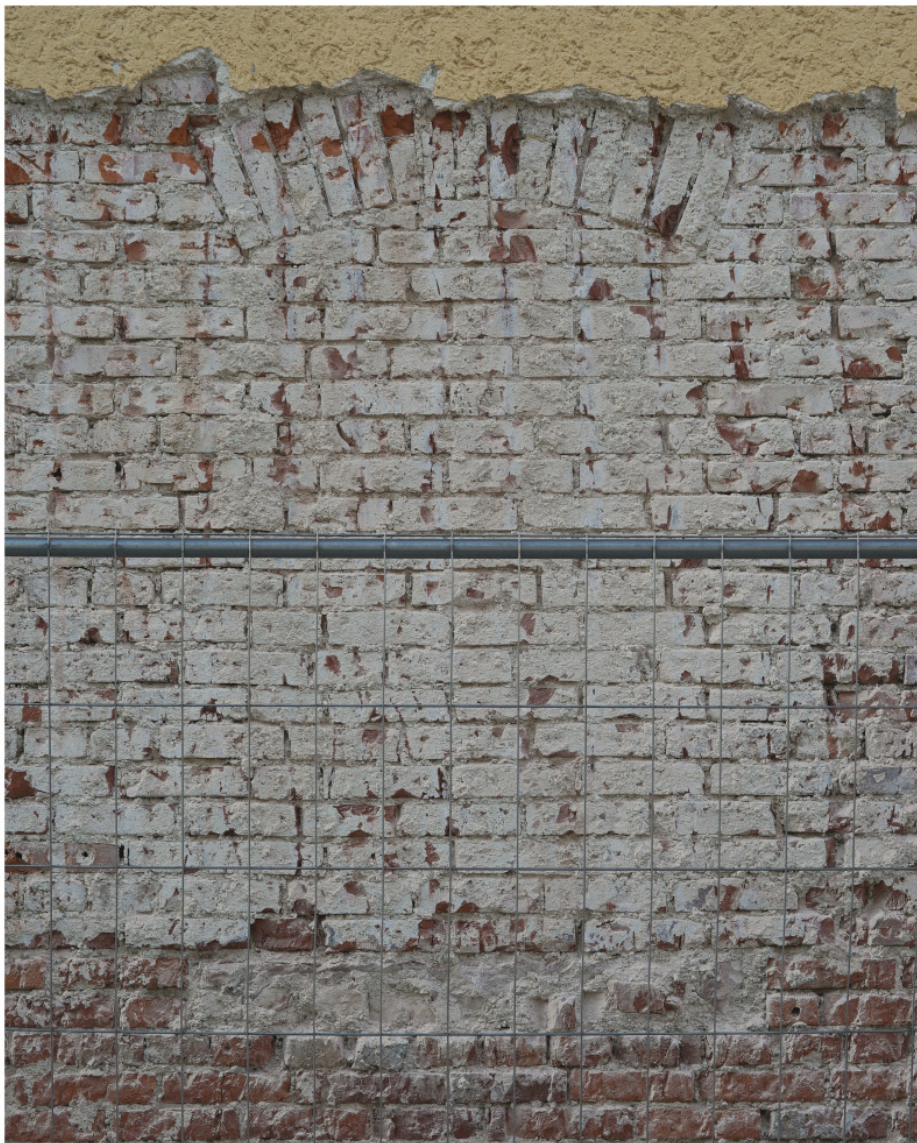
Nr. 70: Scheinfenster an südlicher Giebelseite links, abgeschlagene Fensterbank aus Werkstein, durchlaufende Steinlagen, Stichbogen 7
