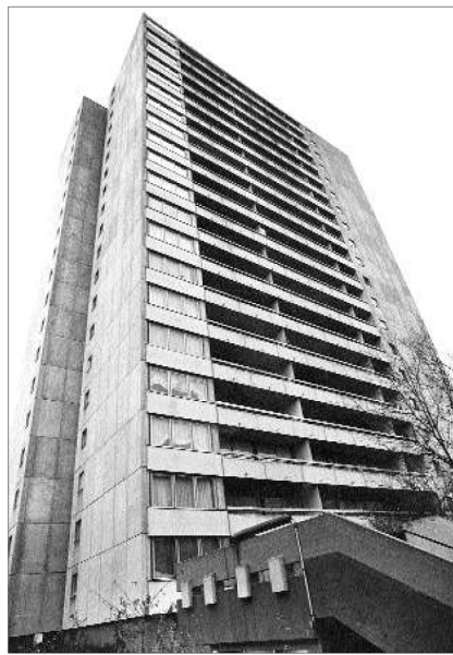
In den letzten Jahren hat die Stadtbau viel Geld in die Sanierung ihres Wohnungsbestandes investiert, der damit natürlich sehr attraktiv für potentielle Käufer ist (Archivfoto: A. Landt)
