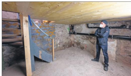
**Dach, Decken, Böden und Keller:** Im Dach und bei den Decken müssen Balken ausgetauscht oder ergänzt werden (oben). Statt der alten Schlackeschüttung kommt Holzfaserdämmung in die Böden (unten links). Die sanierten Keller haben Stehhöhe – für alle, die kleiner als 1,75 Meter sind. (alle Fotos: P. Seeger)
