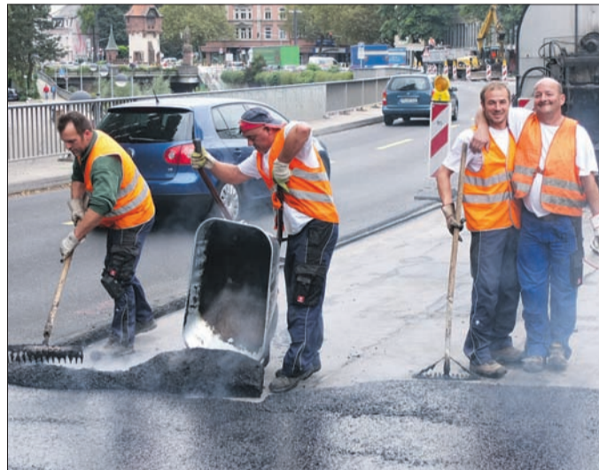
Die Baustelle am Nadelöhr Leo-Wohlleb-Brücke verlief ohne die befürchteten Megastaus. (Foto: A. J. Schmidt)
