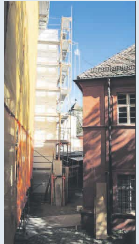
Zwischen dem Gebäude Gerberau (links) und dem Kloster (rechts) ist bereits der Besucher-aufzug entstanden. (Fotos: M. Spiegelhalter)
