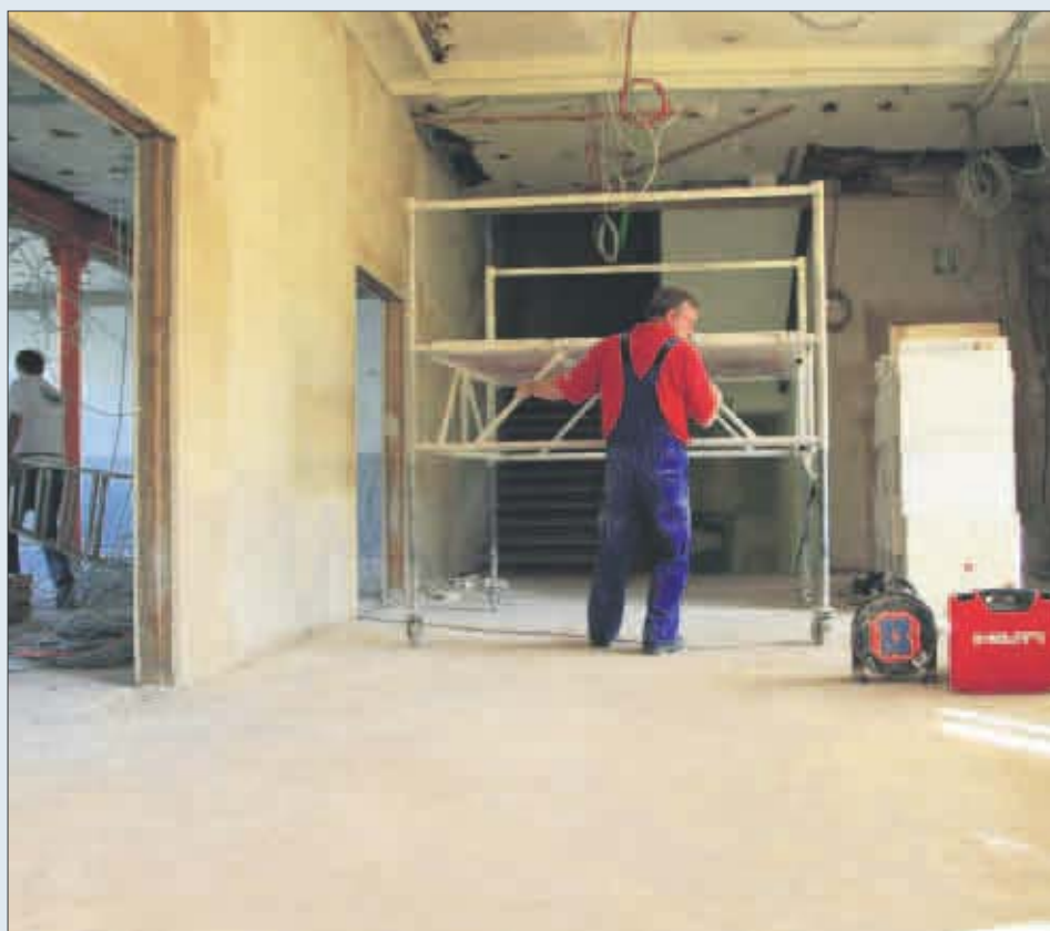
Wo früher die Küken schlüpfen, arbeiten jetzt die Handwerker. Im Gebäude Gerberau werden Böden und Elektrik erneuert und der Brandschutz verbessert. Im Frühjahr sollen die Umbauarbeiten beendet sein, und der Wiederaufbau des Naturmuseums kann beginnen. (Fotos: M. Spiegelhalter / G. Süßbier)
